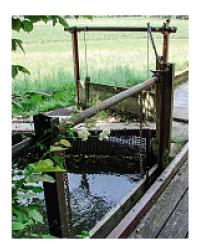
Abzweigung des Mühlenbaches zwischen Mühle und Reibe im Oberlindenholz. Von dieser Schleuse wurden die Matten in der Steinlen hinter dem Gut Unterlindenholz bewässert und später die Mühle im Unterlindenholz angetrieben.
