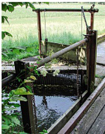
Abzweigung des Mühlenbaches zwischen Mühle und Reibe im Oberlindenholz. Von dieser Schleuse wurden die Matten in der Steinlen hinter dem Gut Unterlindenholz bewässert und später die Mühle im Unterlindenholz angetrieben.
