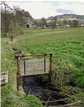
Abbildung 4: Wässergraben mit «Brütsche» zur Ableitung des Wasserwassers im Rottal im Grenzgebiet Bern–Luzern
