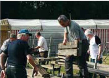
Beim Aufstellen einer Tribüne. Foto Gerhard Ryf, Rumisberg
