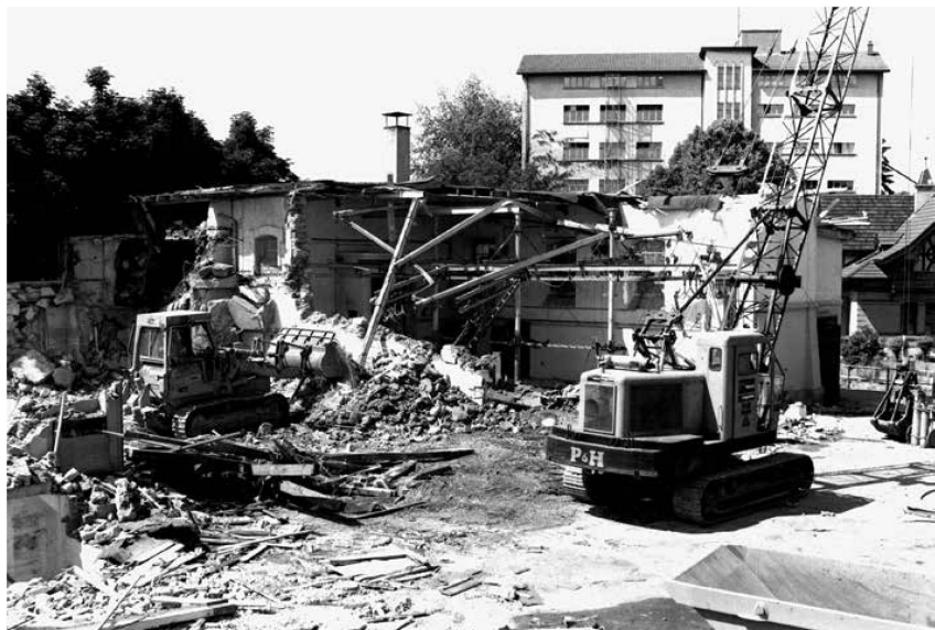
Abriss Schlachthaus im Wuhr 9.–13. Juli 1990. Bild Bauverwaltung Langenthal
