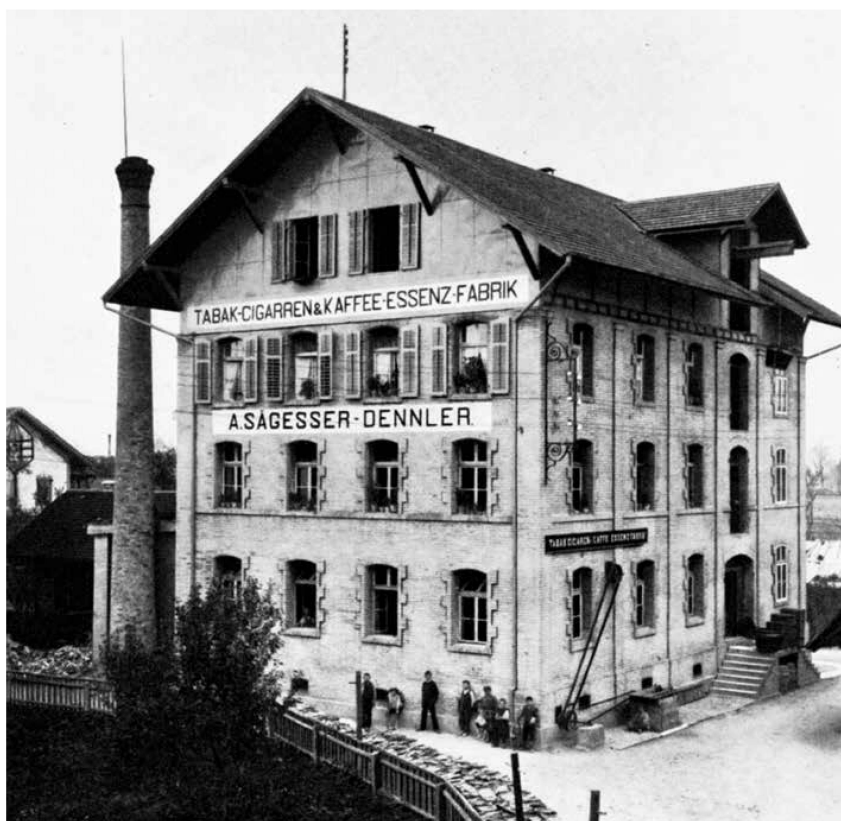
Tabak-, Cigarren und Kaffee- essenzfabrik Sägeser-Dennler, erbaut 1888. Später Möbelfabrik Nyffeler Bild Alt-Langenthal, Nr. 118 Karte 1895, Nr. 4
