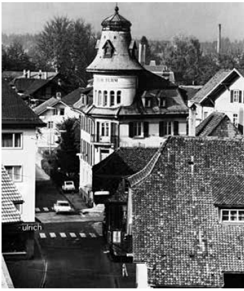
Jurastrasse mit Blick auf Turm. Bild Langenthal 1982, Nr. 305
