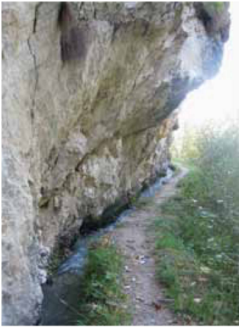
Abb. 7 Suonen, Bisses, Waale: die berühmten Zuleitungen der alpinen Bewässerungsanlagen. Abschnitt der Suone Laldneri im Oberwallis in typischer Ausbildung. Foto Vonderstrass, 2009
