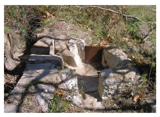
Abb. 15 Analoge Technik: Diese Konstruktion einer Verteileranlage in der Sierra Nevada in Andalusien könnte auch in andern europäischen Gebirgsregionen anzutreffen sein. Foto Vonderstrass, 2006
