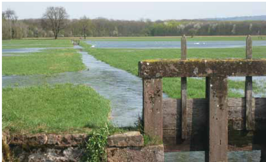
Abb. 9 Vorlandbewässerung in den Elzwiesen im südlichen Oberrhein. Als neuere Anlage ist sie geometrischer angelegt als das gewachsene Verteilersystem im Oberraargau. Dennoch sind Ähnlichkeiten dieser Rückebewässerungsanlagen mit den oberraargauischen unverkennbar. Foto Vonderstrass, 2011
