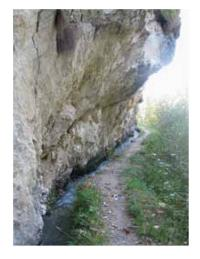
Abb. 7 Suonen, Bisses, Waale: die berühmten Zuleitungen der alpinen Bewässerungsanlagen. Abschnitt der Suone Laldneri im Oberwallis in typischer Ausbildung. Foto Vonderstrass, 2009
