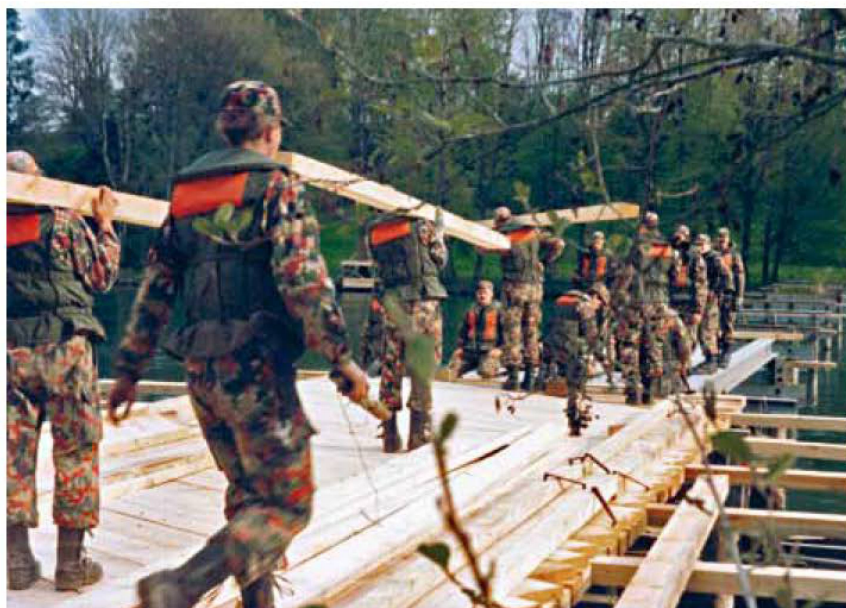
Brückenbau der Pontoniere mit behelfsmässigem DIN-Brückenmaterial, 1991 beim Gumenwäldli, Aarwangen. Foto Verfasser
