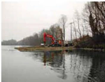
Kiesschüttungen zur Verbesserung des Geschiebehaushaltes
