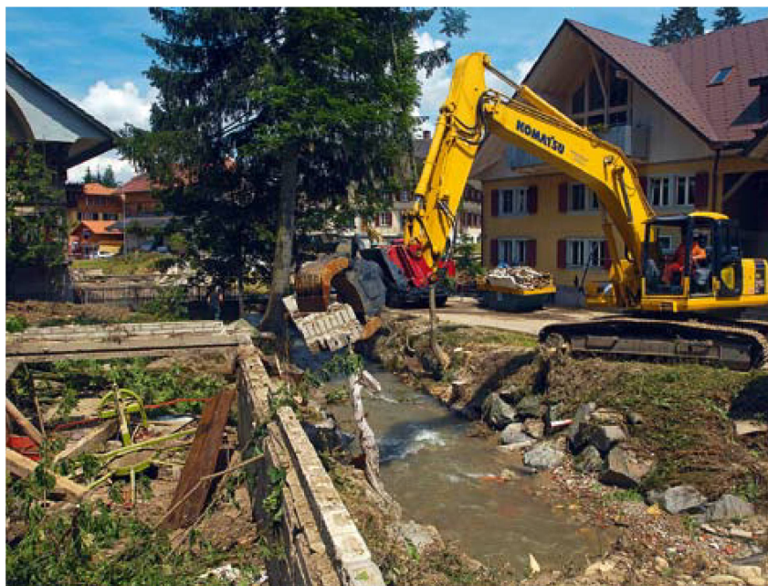
Schwere Maschinen befreien in Eriswil das Bachbett der Langeten vom Geschiebe des Hochwassers.
