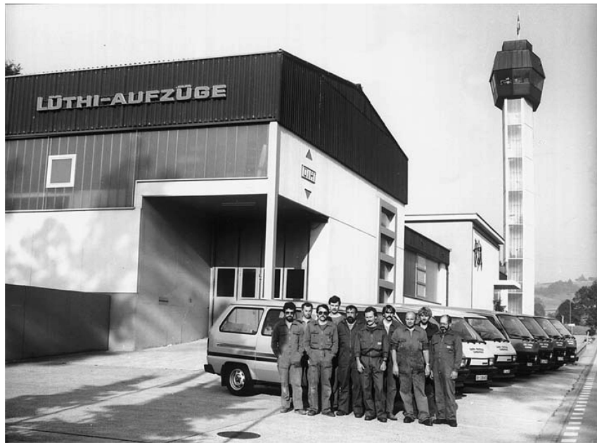
Das Service- und Montageteam mit seiner Fahrzeugflotte vor der Fabrik um 1980
