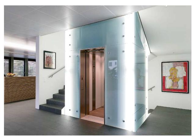
Für eine Versicherung in Konolfingen entstand dieser Lift. Er musste ins Treppenhaus eines bestehenden Gebäudes eingepasst werden. Gemäss den Vorstellungen des Architekten wurde ein Schacht aus hinterleuchtetem Opakglas erstellt, das mit einer speziellen Punkthalterung befestigt wird. Der Lift erhellt so zugleich das Treppenhaus.
