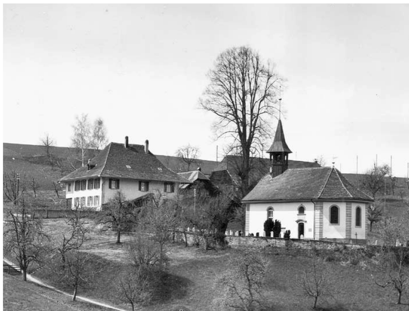
Kirche und Pfarrhaus Walterswil. Ansicht von Osten. Foto Denkmalpflege des Kantons Bern
