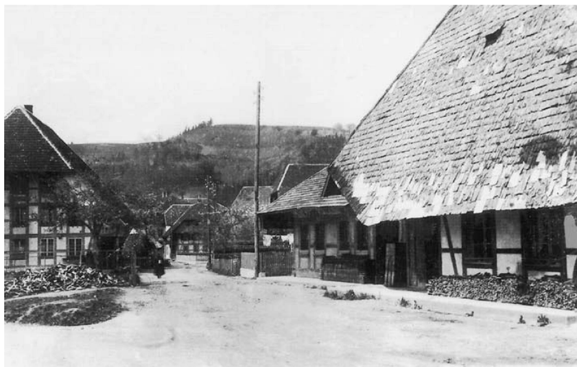
Einmündung der Schulhausstrasse in die Hauptstrasse
