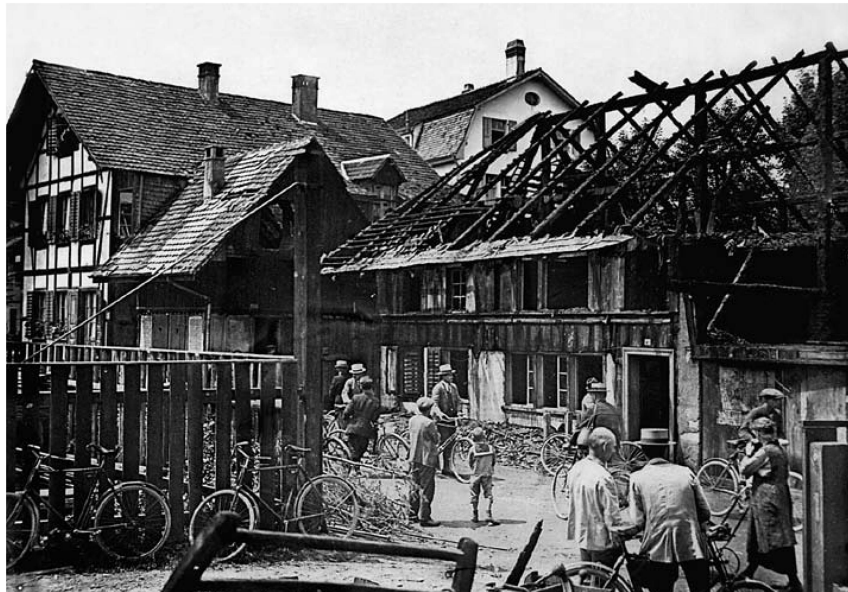
Haus Nr. 38 Brand vom 9. Juli 1924. Das Überspringen des Feuers auf die Nachbarhäuser kann zwar nicht verhindert, der Schaden aber doch begrenzt werden. Im Hintergrund links Haus Nr. 44 und (Mitte) das alte Heilsarmee- haus, Nr. 46
