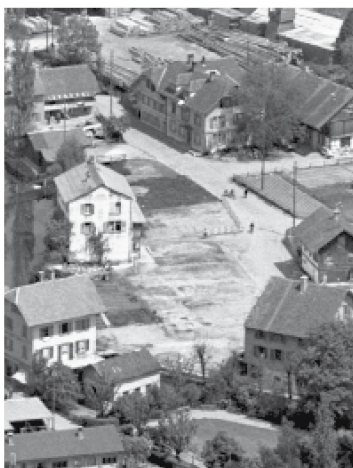
Das alte «Heilsarmeehaus» 1948 als Pièce de résistance in der Diskussion um die Neugestaltung des Gebietes an der Hauptgasse. Mit Rücksicht auf den Wohnungsmarkt beschliesst der Gemeinderat, mit dem Abbruch zuzuwarten. Fotos Firma Hector Egger (oben), Alpar Bern (unten)
