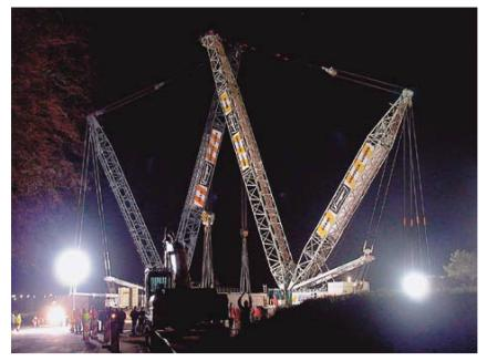
32 Meter lang, 310 Tonnen Gewicht: Der erste Brückenträger wird kurz nach Mitternacht auf den Boden gesetzt.
