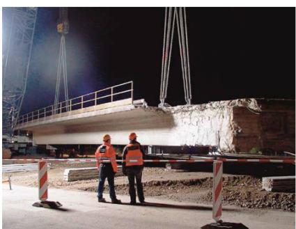
nötige Festigkeit erhielten und freitragend die Strasse auf einer Breite von 32 Metern überqueren konnten. Die Untersuchung der Brücken findet im Rahmen des Forschungsprojektes ZEBRA (Zustandserfassung von Brücken bei deren Abbruch) statt, das unter der Führung der ETH Zürich steht.
