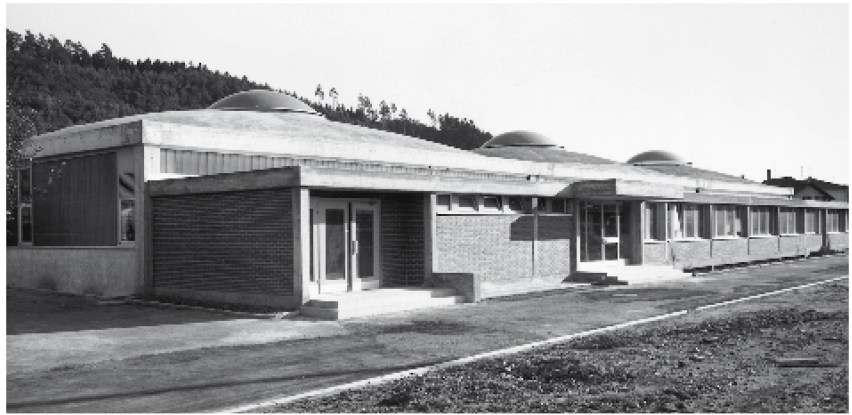
Neubau an der Zeughausstrasse 19 in Wangen (1964). Foto Roth, Herzogenbuchsee
