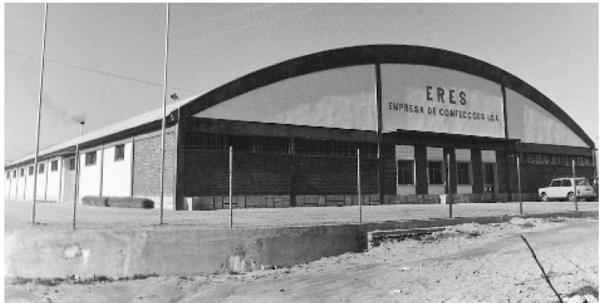
Neubau der ERES – Empresa de Confecções, Lda. in P-Fundão (1972)
