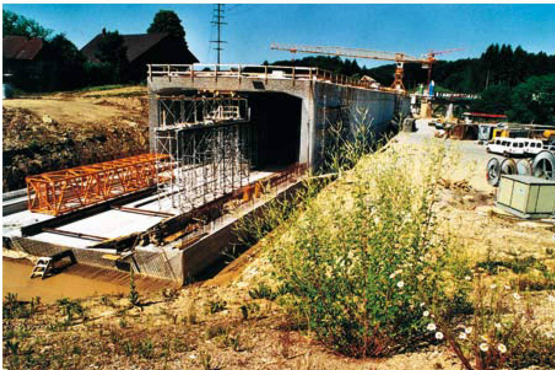
Tunnel Gishübel, Wanzwil, Aussenansicht der Baustelle
