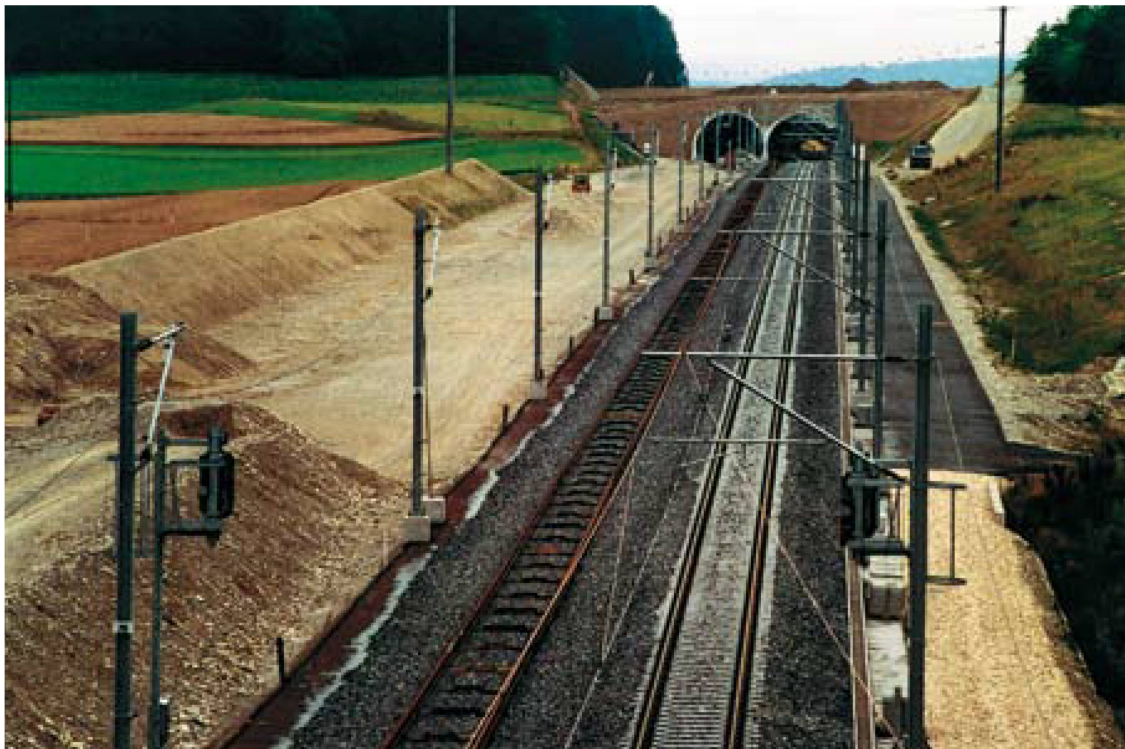
Die Geleise der verlegten Stammlinie bei Bützberg
