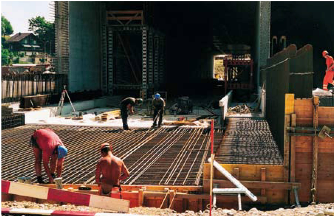
Arbeit am Tunnel Gishübel, Wanzwil
