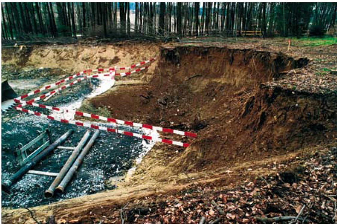
Abrisskante der Einsturzstelle
