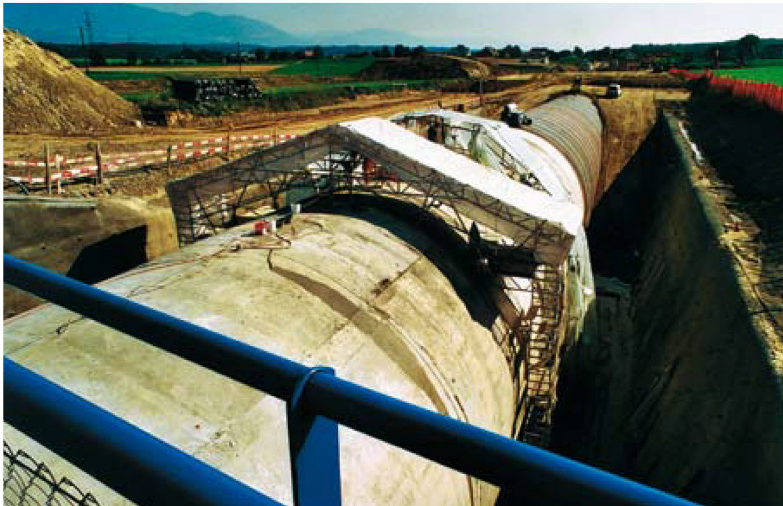
Aeschi, Tunnelröhre des Önzbergtunnels (Teil Tagbau)
