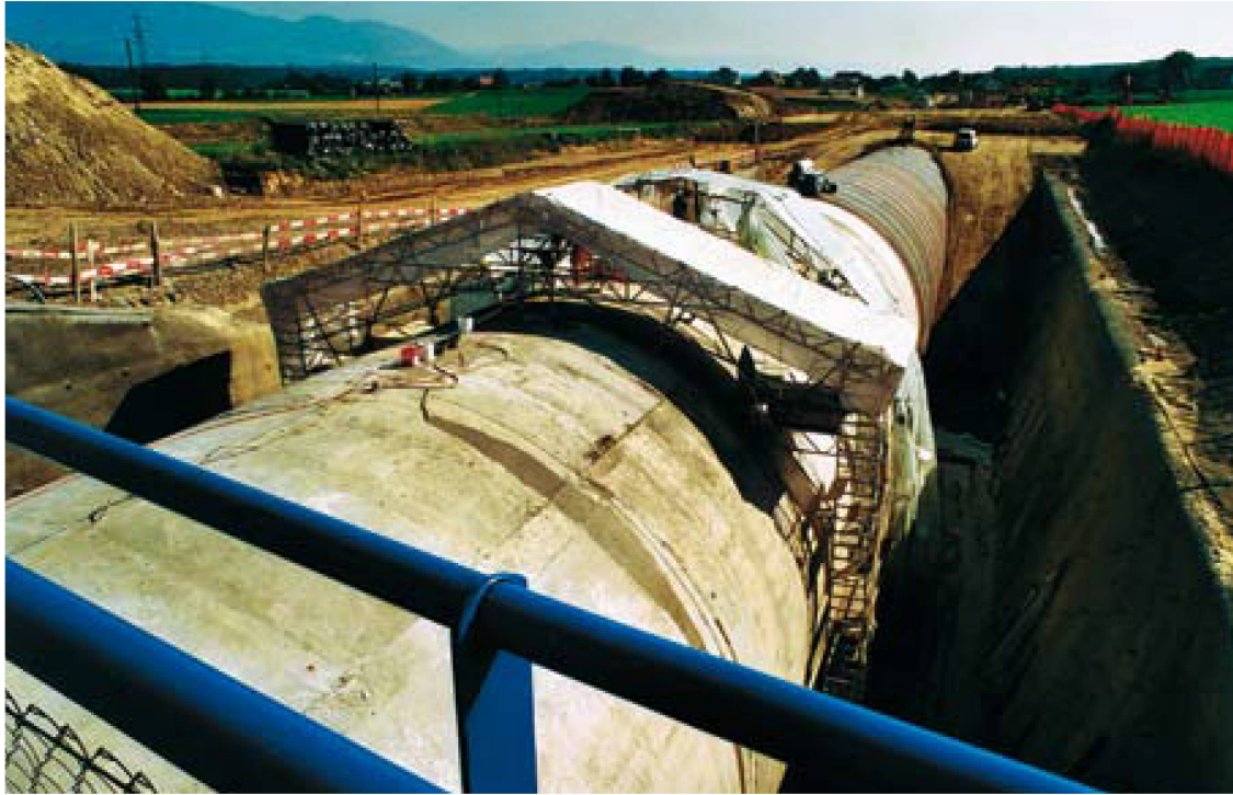
Aeschi, Tunnelröhre des Önzbergtunnels (Teil Tagbau)
