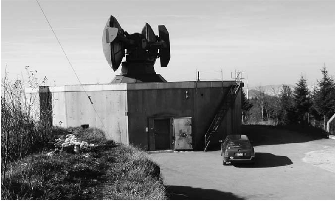
Die Radaranlage: Unten der splittergeschützte Kommando- und Geräteraum, oben die drehbaren Haupt- und Nebenantennen.
