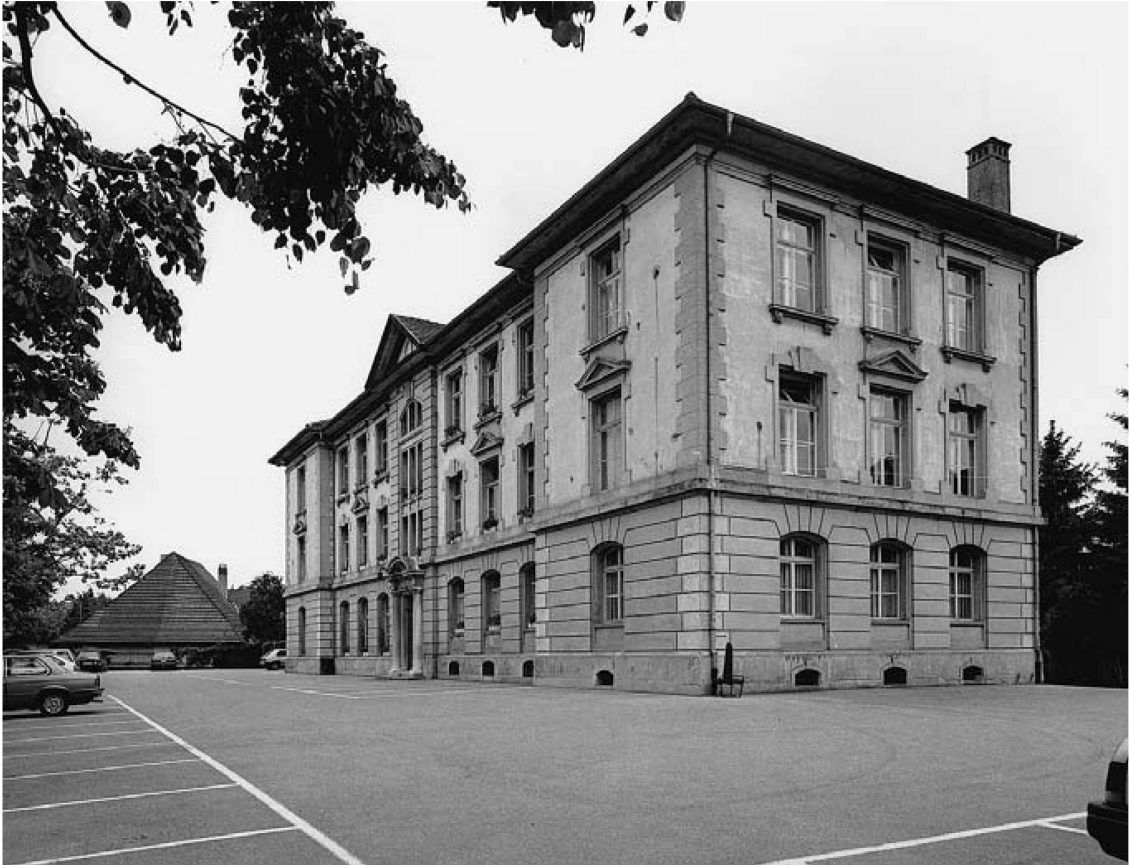
Bild 8: Das «verlassene» Schulhaus, nach 1983. Foto Kantonale Denkmalpflege
