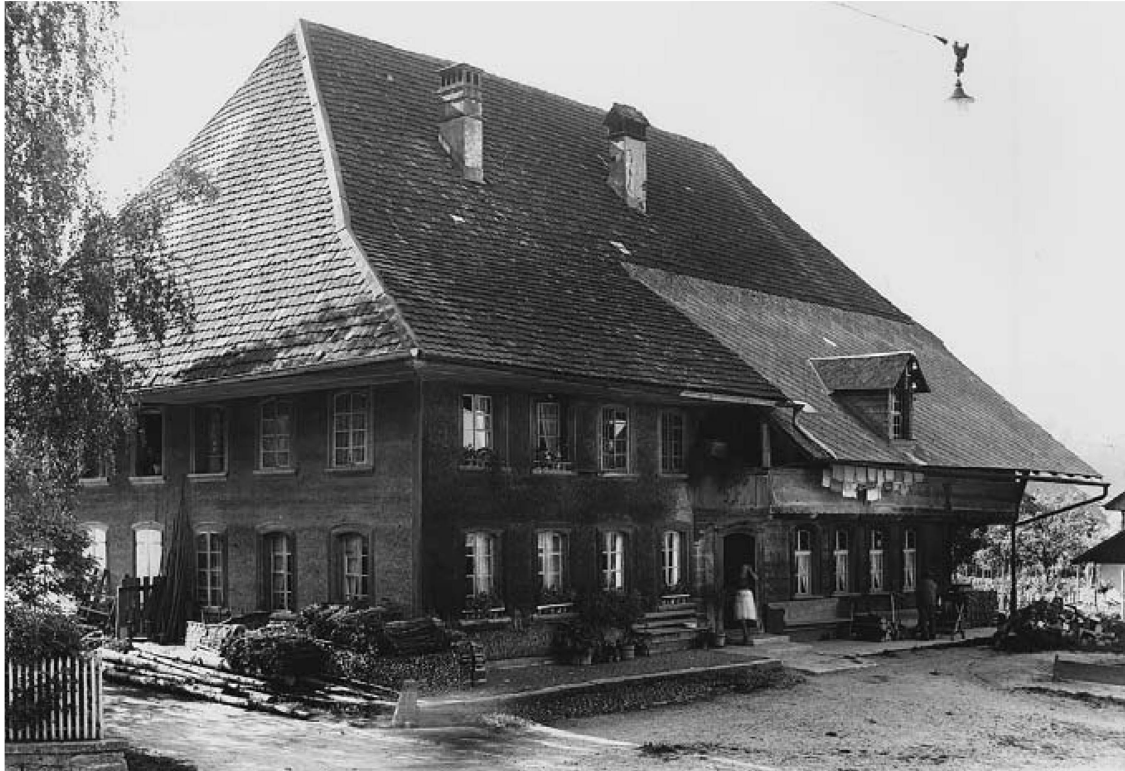
Bild 4: Das alte Schulhaus auf dem Kirchplatz. Foto Kantonale Denkmalpflege
