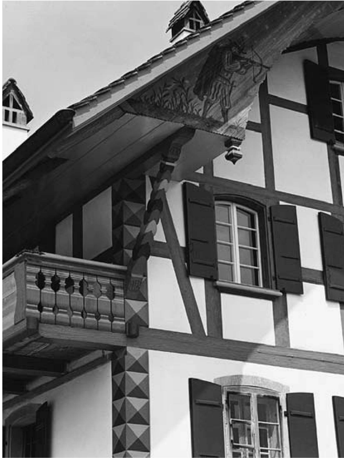
Abb. 3: Scheinarchitektonisch aufgemalte Eckklisenen am Birlihofstock. Foto Denkmalpflege des Kantons Bern, Gerhard Howald, Kirchlindach
