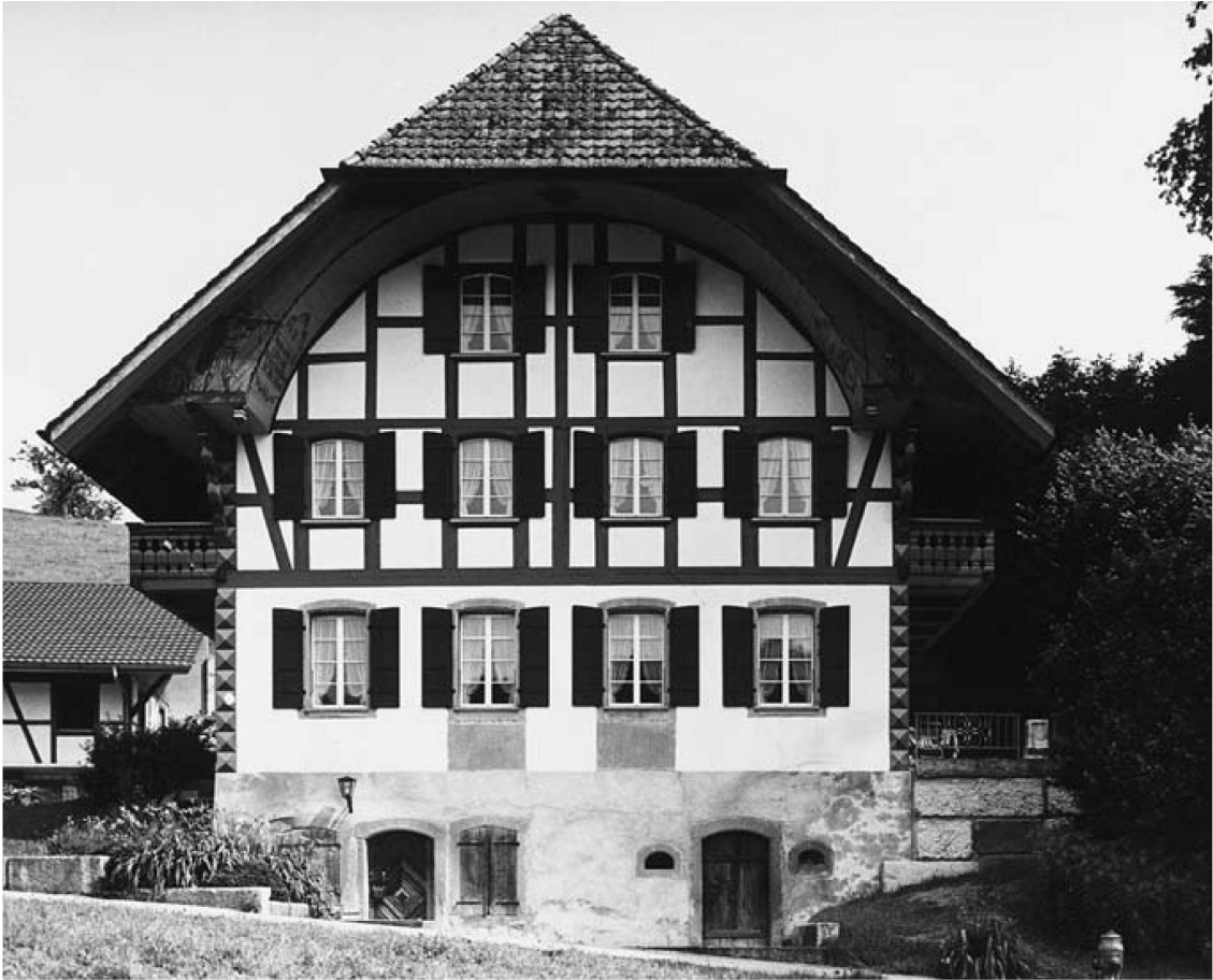
Abb. 2: Gesamtansicht des Birlihofstockes von Süden
