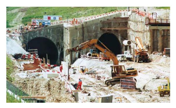
Eine der grössten Baustellen: der Önzberg bei Wanzwil. Im Mai 2001 sind die Portale der Tunnel Önzberg (links) und Wolfacher Nord erstellt und ein erster Teil der beiden Tunnels mit kleinen Maschinen gebohrt. Das Trassee der Zufahrten ist noch im Bau. Fotos Verfasser
