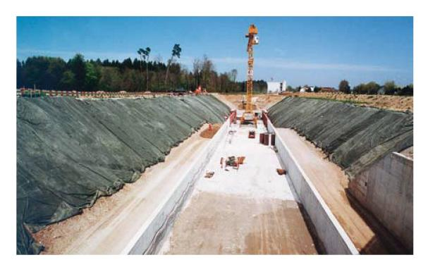
Bau der Grundwasserwanne im Gebiet Dreilinden, Langenthal. Weil die Neubaustrecke im Hard das Grundwassergebiet durchquert, werden beidseits des Tunnels Langenthal (auf dem Bild nicht sichtbar) derartige betonierte Wannen erstellt. Sie sollen Verschmutzungen des Grundwassers (z.B. bei einem Unfall) verhindern.
