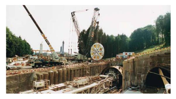
31. Juli 2001: Der grösste Hebekran der Schweiz zieht den Bohrkopf (Mitte hinten) für die grosse Bohrmaschine des Önzbergtunnels auf. Der Kopf hat einen Durchmesser von 12 Metern und ist 200 Tonnen schwer. Auf dem betonierten Trassee ist die Bohrmaschine in Montage (unten).
