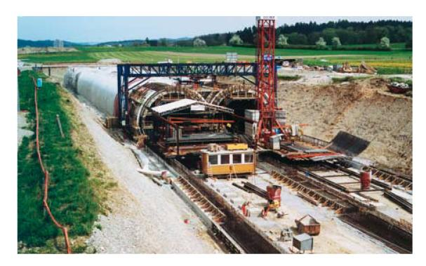
Der Tunnel Thunstetten wird im Tagbau erstellt. Im Bild die Situation im Byfang (Mai 2001). Die beiden Röhren wachsen im Rekordtempo von 18 Metern pro Woche. Ein Teil des Tunnels ist im Sommer 2001 bereits wieder zugedeckt.
