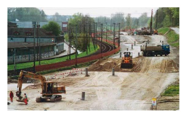
In der Senke nordwestlich von Roggwil verläuft die Neubaustrecke am Rand des Gugelmann-Areals (links). Die Geleise der alten SBB-Stammlinie werden zwischen Langenthal und Roggwil später parallel zur Bahn 2000 geführt. Die Betonpfeiler dienen der Stabilisierung des Hanges rechts, der ganz leicht in Bewegung ist.
