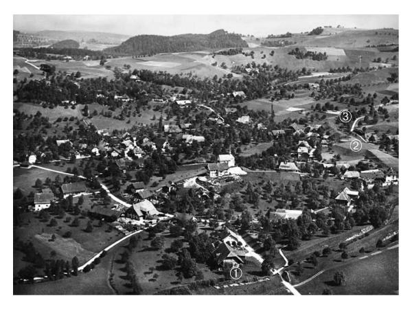
Altbüron in den 1930er Jahren. Der Bahndamm beginnt in der Bildmitte vorne (1), verläuft dann an den rechten Bildrand, wo das verbreiterte Plateau für den Bahnhof auffällt (2), um dann nach rechts in einen Einschnitt und schliesslich in den Tunnel zu münden (3). Foto Alpar
