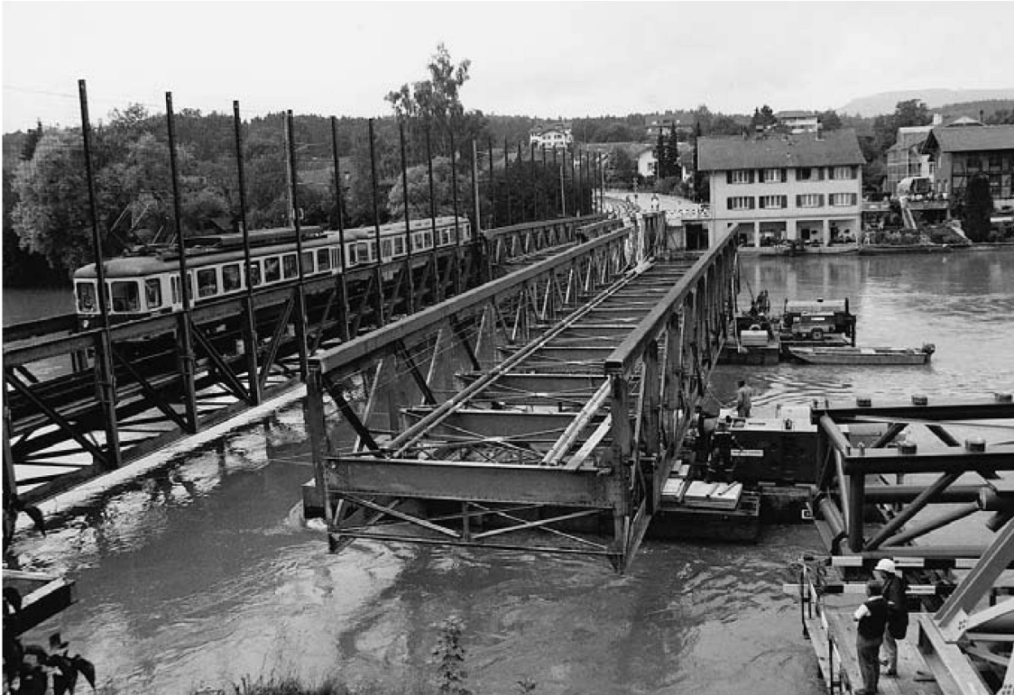
Alte Brücke von 1889, Fahrbahn bereits entfernt. Foto Ursula Wittwer
