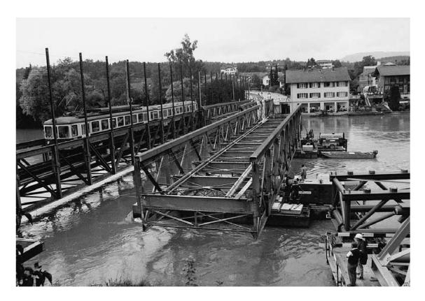
Alte Brücke von 1889, Fahrbahn bereits entfernt. Foto Ursula Wittwer
