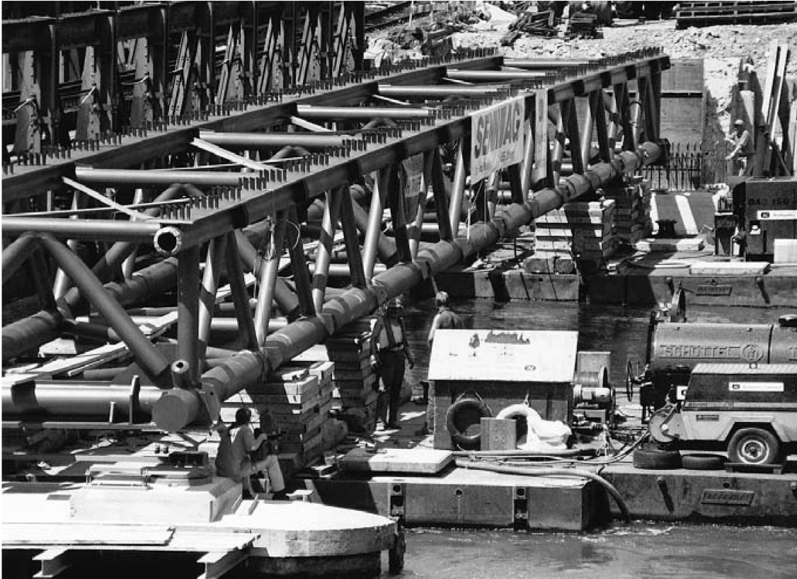
Neuer Fachwerkträger am 16.7.1997 beim Absenken auf die Lager. Foto Ursula Wittwer
