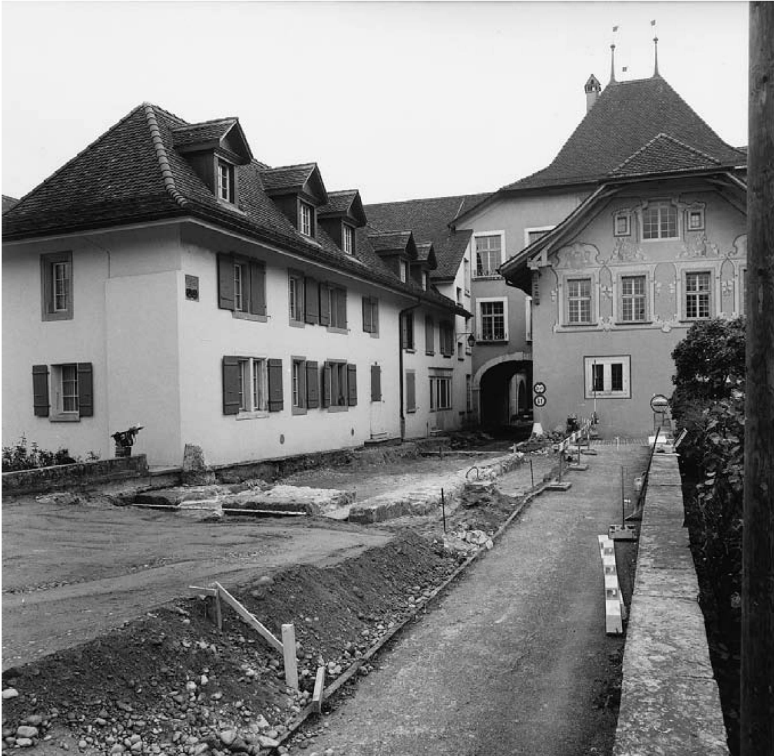
Übersicht von Nordwesten auf die Maueraufschlüsse von Brückenpfeiler und Vorwerk des Untertores. Foto Archäologischer Dienst des Kt. Bern (ADB)
