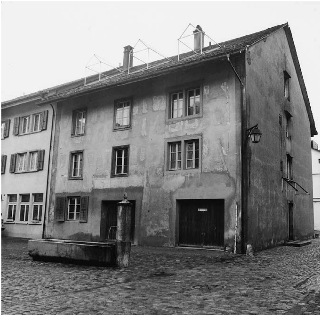
Städtli 60. Ansicht des Hauses von Nordwesten vor seinem Abbruch (Aufnahme vom 13.12.1993). Foto Archäologischer Dienst des Kt. Bern (ADB)
