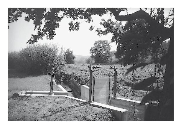
Abb. 7: Wiederherstellung der Wässeranlagen am Beispiel der renovierten Bärtschi-Brütsche in den sog. Langetematten. Foto V. Binggeli 1998.
