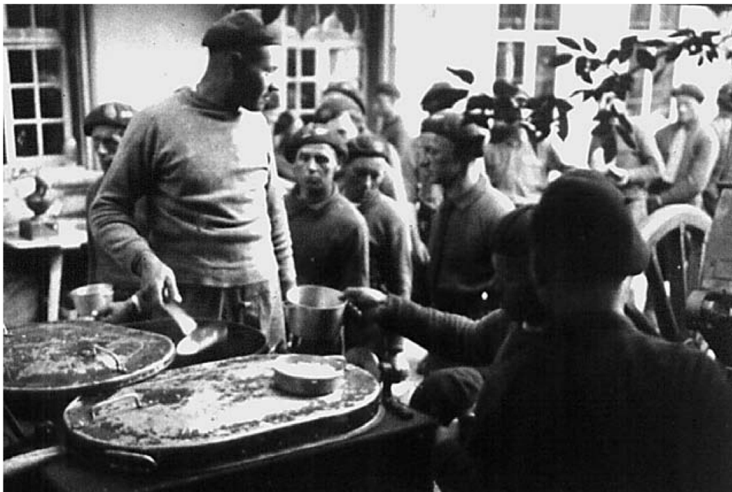
An einer mobilen Küche der Internierten in Sumiswald wird das Essen geschöpft. Aufnahme Friedrich von Steiger.
