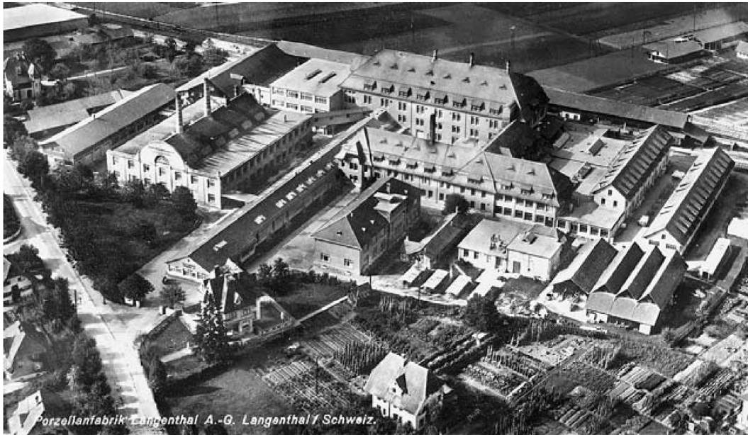
Porzellanfabrik Langenthal. Luftaufnahme von 1939. Foto O. Wyrsh, Wabern.
