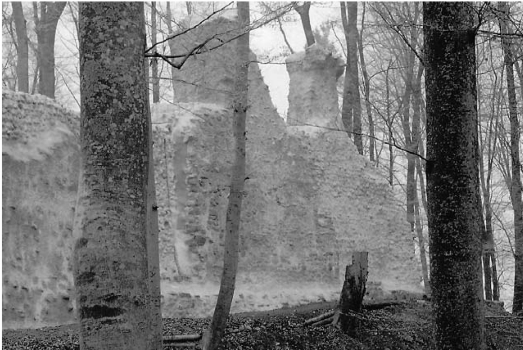
Südansicht der Grünenberg nach der Sanierung 1993. Foto ADB.
