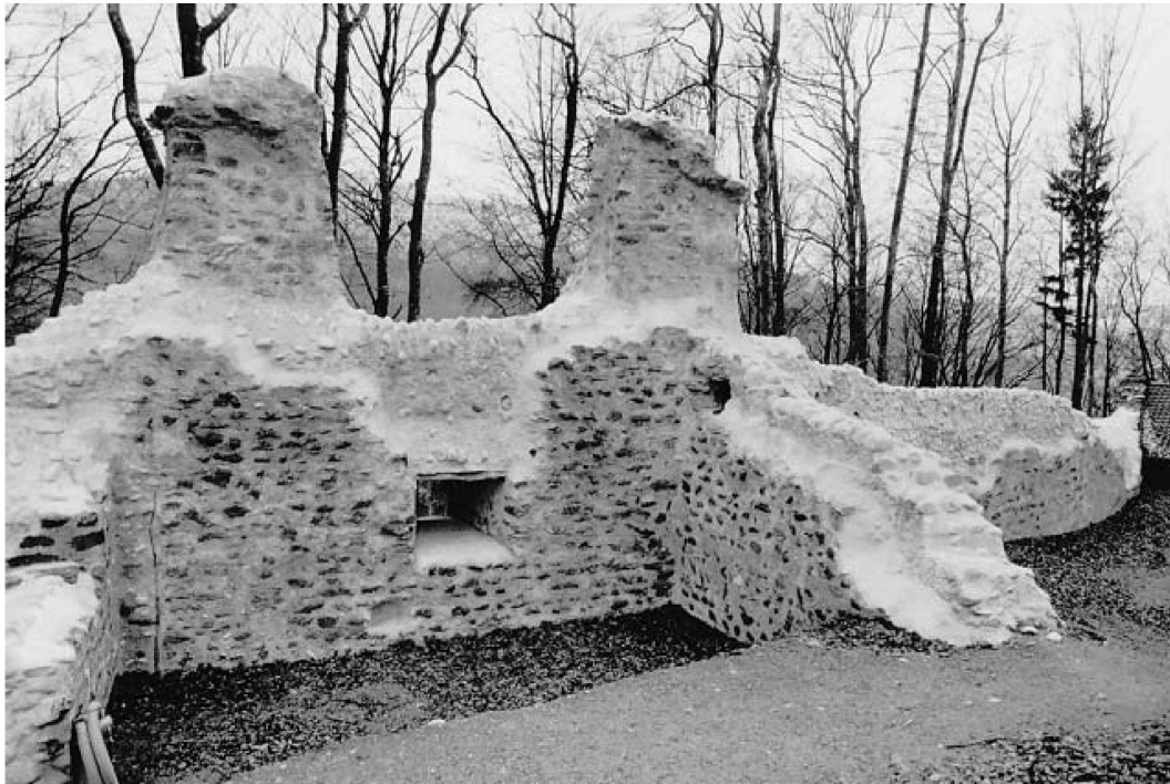
Südmauer der Grünberg vom Hof aus gesehen nach der Sanierung 1993. Foto Margrit Kohler, Langenthal.
