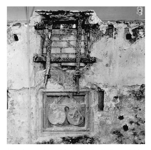
Abb. 9: Sakramentsnische und Reliefplatte in der Nordwand des Chores. Die Aufnahme zeigt den angetroffenen Zustand mit der vermauerten Wandnische, die später freigelegt wurde.
