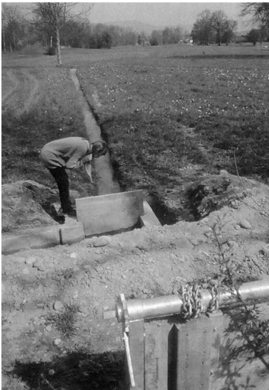
Wiederherstellungsarbeiten April 1993 bei der Bühlerschwelle unterhalb von Lotzwil. Verteiler im Bau. Foto V. Binggeli.
