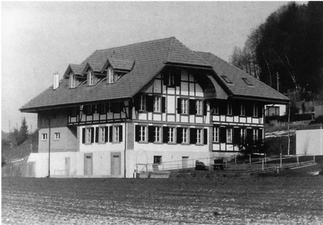
Ehemaliges Schulhaus Riedtwil. Sinnvolle Nutzung durch neues Leben. Foto Walter Gfeller, Herzogenbuchsee.
