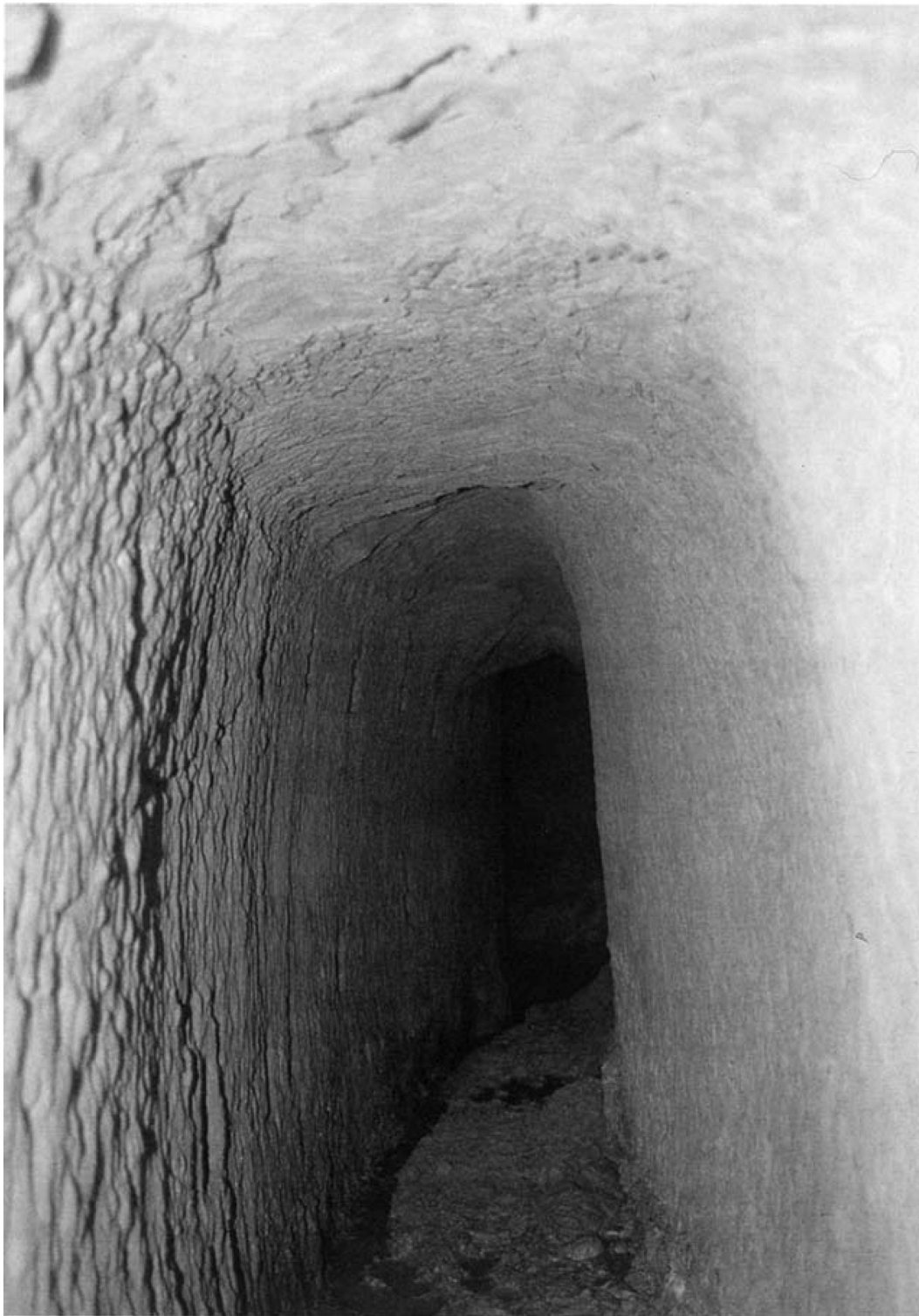
Abb. 7: Brunnenstollen Sennjögger in den Teilabschnitten Ia und Ib (im Sandstein) rund 200 m im Bergesinneren. Foto I. Vonderstrass
