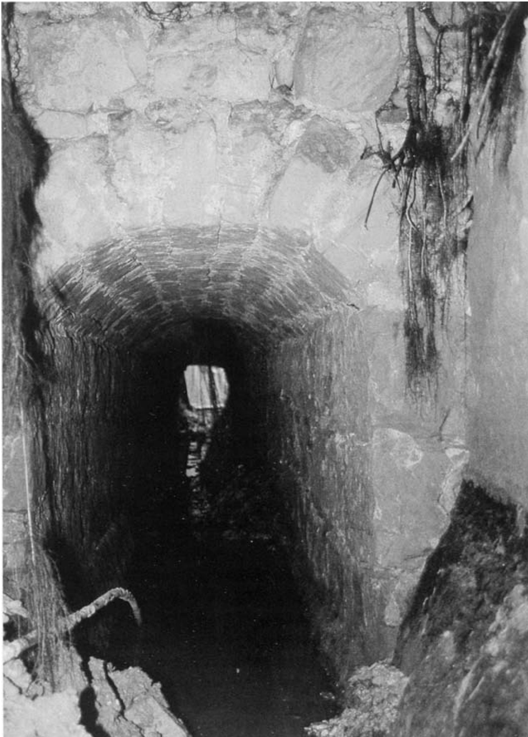
Abb. 11: Brunnenstollen Sennjöggel im Eingangsbereich. Die ersten 18m sind im Gewölbe als Trockenmauer ausgebaut. Blick in Richtung Ausgang. Rechts oben eingewachsene Baumwurzeln. An der Aufnahmestelle lag früher der Sodbrunnen.
