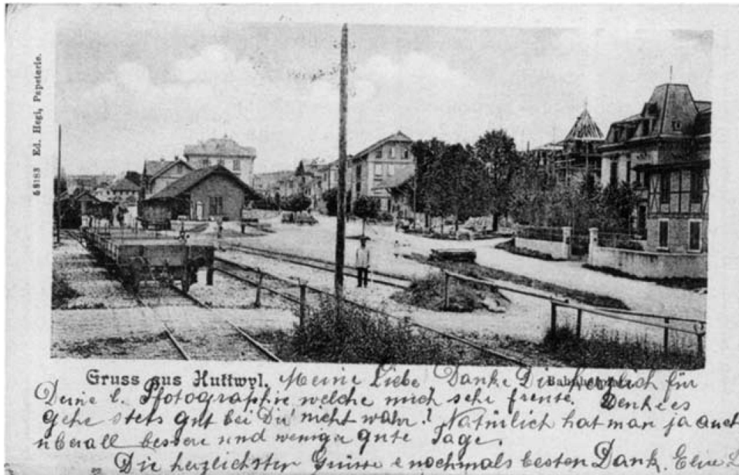
Der Bahnübergang Walkenstrasse bei der Einfahrt der Züge von Langenthal in den Bahnhof Huttwil um die Jahrhundertwende. Man beachte die geschlossene Bahnschranke!
