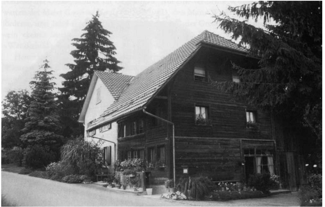
Busswil, Haus Schulthess. Das Vollwalmdach wurde zum Krüppel Walmdach, der First bildet heute mit dem Massiv-Anbau einen Kreuzfirst. Foto Christoph Geiser, 22. Juli 1987
