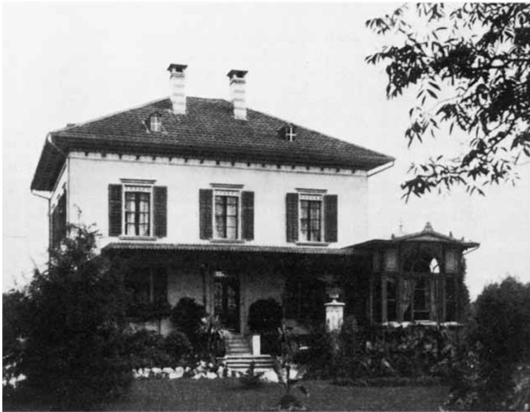
Das Nationalrat-Bützberger-Haus an der Lotzwilstrasse in Langenthal, Mittelpunkt der oberaargauischen Radikalen. Unter dem späteren Besitzer Oberförster von Erlach war es als «Forsthaus» bekannt. 1974 musste es einer Überbauung weichen. Aus: Text- und Bildband «Langenthal». Foto H. Zaugg.
