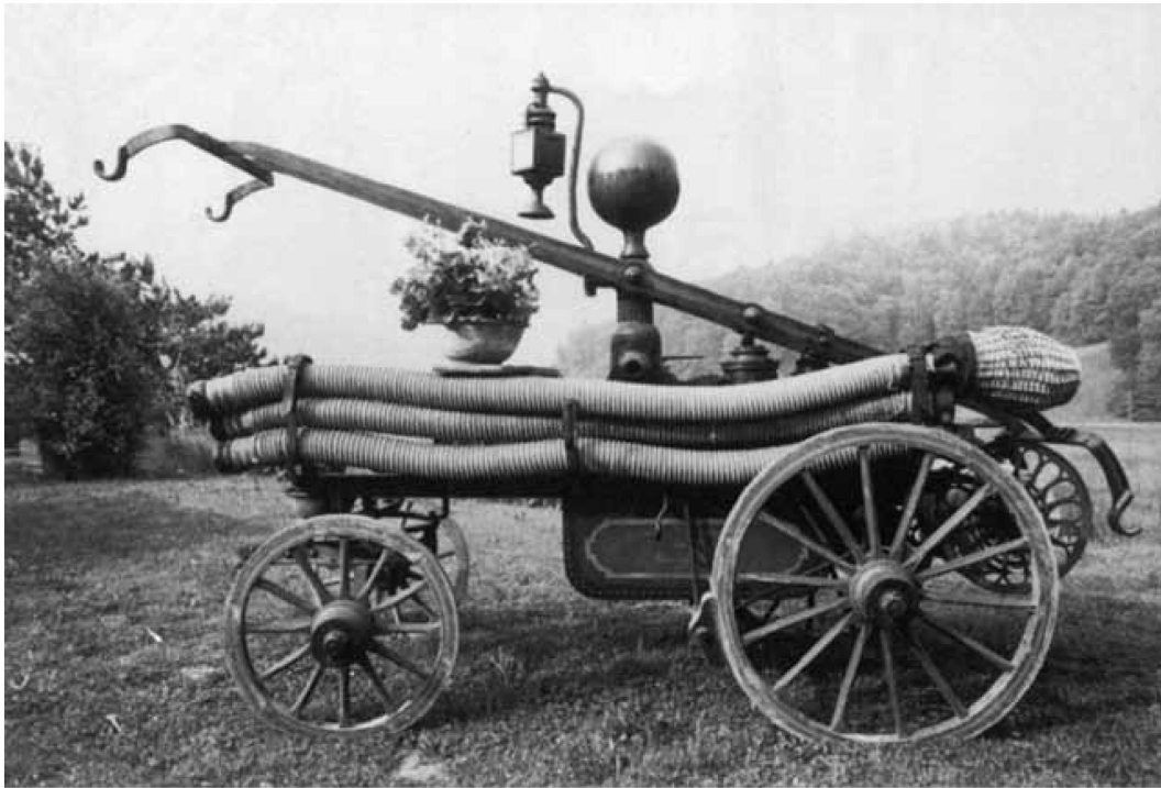
Stalder-Spritze mit Windkessel, Hermiswil 1885
