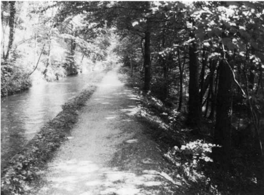
Der Rothkanal wird mit Hilfe eines Dammes mit wenig Gefälle dem Buchwald entlang gegen Rothrist geführt. Foto Valentin Leibundgut
