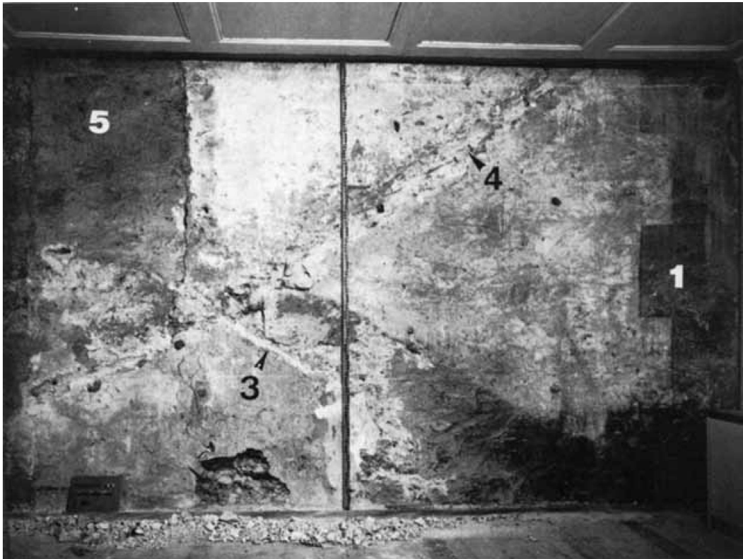
26 Ansicht an die östliche Zeitglockenturmmauer im Bereich des 1. Obergeschosses. 1 Spätgotische Eckquaderbemalung, 3 Dachlinie des älteren Schreibstubenbaus im Hof, 4 Dachlinie des Dünz'schen Landschreibereigebäudes im Hof, 5 vermauerte Türöffnung zum mittelalterlichen Wehrgang der Stadtmauer. Vgl. Beilage 4.
