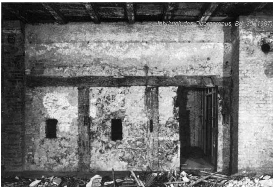
21 Nordseite des Ständerwerks von 1570 mit jüngerer Ausfachung und Fensterchen (vgl. Beilage 6: 9–12).
