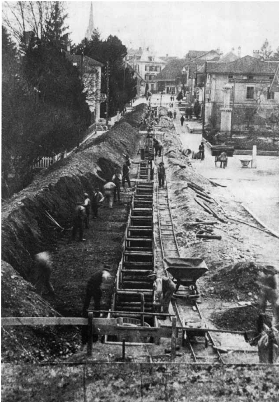
Kanalisationsarbeiten an der Bahnhofstrasse.
