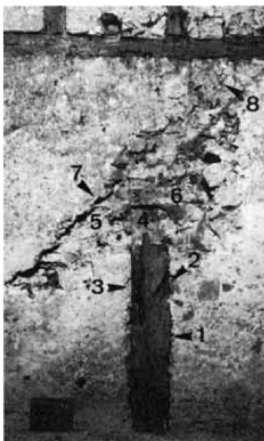
Abb. 10: Abdrücke des Ständerbaus in der Nordmauer des Hauses Nr. 17. Vgl. Abb. 11.— 1 Eckständer, 2 Sperrafe, 3 Kopfholz, 4 Rähmbalken bzw. Wandpfette, 5 Rafe, 6 Keilholz, 7 Dachlattung, 8 Biberschwanzziegel.
