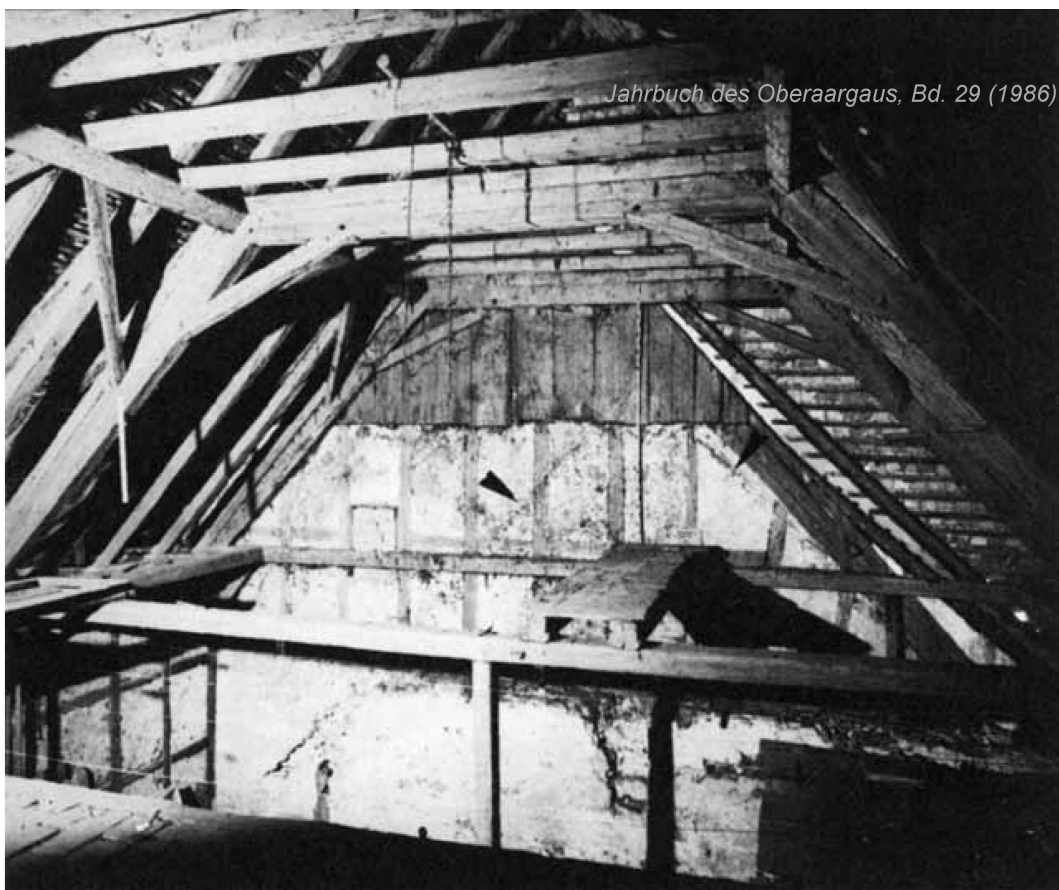
Abb. 9: Blick von Nordwesten in den Dachraum des Hauses Nr. 15. Deutlich sichtbar sind die Konturen des Ständerbaus (Pfeil) an der Südwand gegen Haus Nr. 17.
