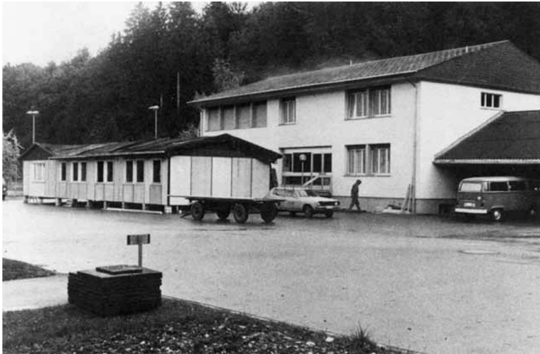
Das Theorie- und Kursgebäude im Zivilschutz-Ausbildungszentrum Aarwangen. Im Vordergrund der durch die erweiterte Kurstätigkeit nötige, nachträglich im Jahr 1980 errichtete Ausbildungspavillon. Foto Otto Neuenschwander
