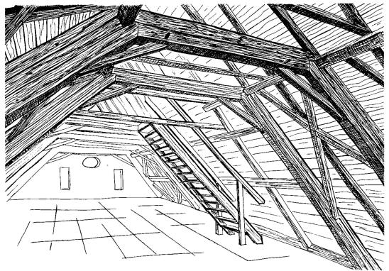
Abb. 8. Die mächtigen Strebebalken des Dachstocks. Zeichnung W. Gfeller
