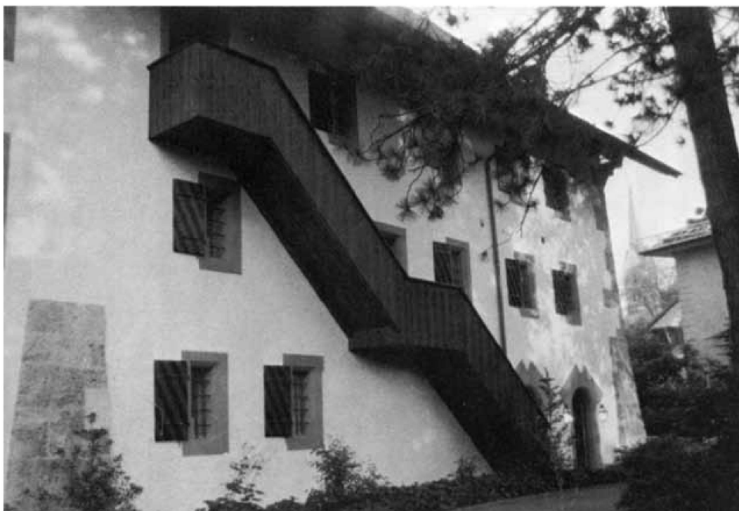
Abb. 3. Die Aussentreppe wurde nach den alten abgesägten Balken rekonstruiert und gliedert jetzt mit ihrem kräftigen Bau die ganze Seite. Sie gab dem Verfasser Anstoss zum Kornhaus-Signet. Foto W. Gfeller
