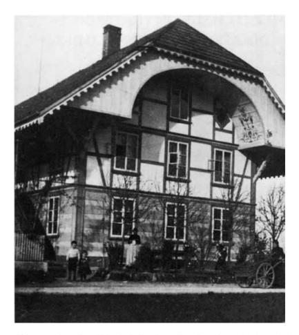
Abb. 1 und 2. Deutlich sind die ehemalige Bemalung der Fassade im Erdgeschoss (graue Streifen), in den Obergeschossen (Riegfelder) und die Ründimalerei zu erkennen. Foto um 1910.
