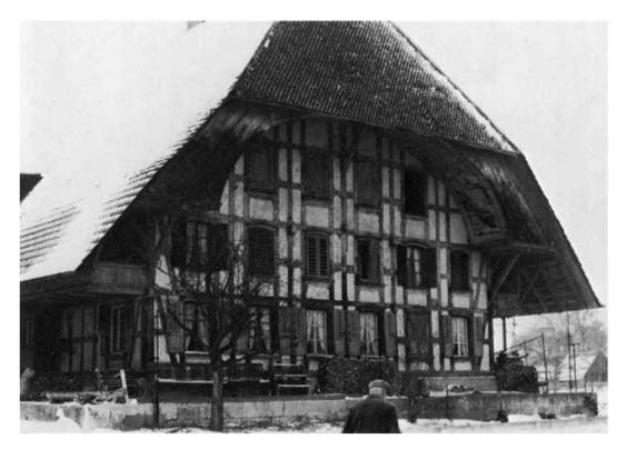
Abb. 4. Haus mit Dreiviertelwalm und Ründe, der Nachfolgebau des Hochstudhauses und zugleich der Höhepunkt bernischer Zimmermannskunst oberaargauischer Prägung. Solche Häuser liessen habliche Bauern erstellen. Das reich geständerte Fachwerk und die gezupften Büge verraten einen Bauernstand, der zu den wohlhabendsten in ganz Europa gezählt wurde (Koppigen, Strasse nach Utzenstorf). Foto W. Gfeller
