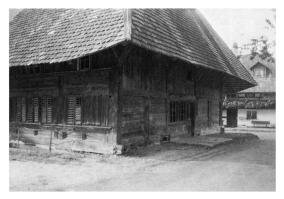
Abb. 16. Hochstudhaus Ecke Jägerweg-Länggasse Herzogenbuchsee. Nur die Küche hat Fenster; das Loch im Gadengeschoss ist nicht original, hingegen die hier nicht sichtbaren Rauchschlitze der Rauchkammer. Die laubenlose und fensterarme Giebelseite steht im Gegensatz zu den beiden Traufseiten. Eines der wenigen Häuser, mit denen sich das abgebrochene Gebäude in Niederönz vergleichen lässt, wenngleich das hier abgebildete Haus beträchtlich höher gebaut ist. Foto W. Gfeller
