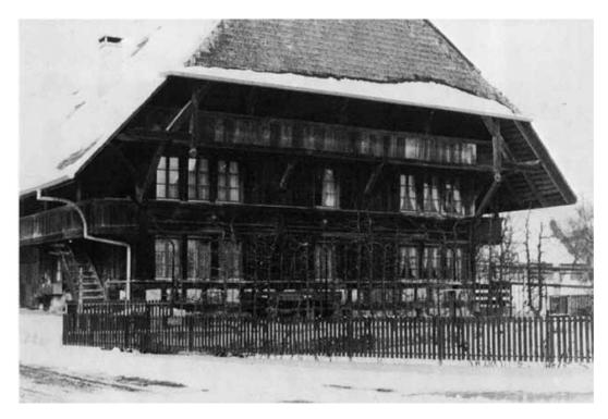
Abb. 5. Haus mit Dreiviertelwalm, einer im Emmental und Oberaargau verbreiteten Dachform des Holzhauses. Markanter Bau am Eingang zur alten, engeren Dorfsiedlung von Herzogenbuchsee, Thörigenstrasse. Foto W. Gfeller
