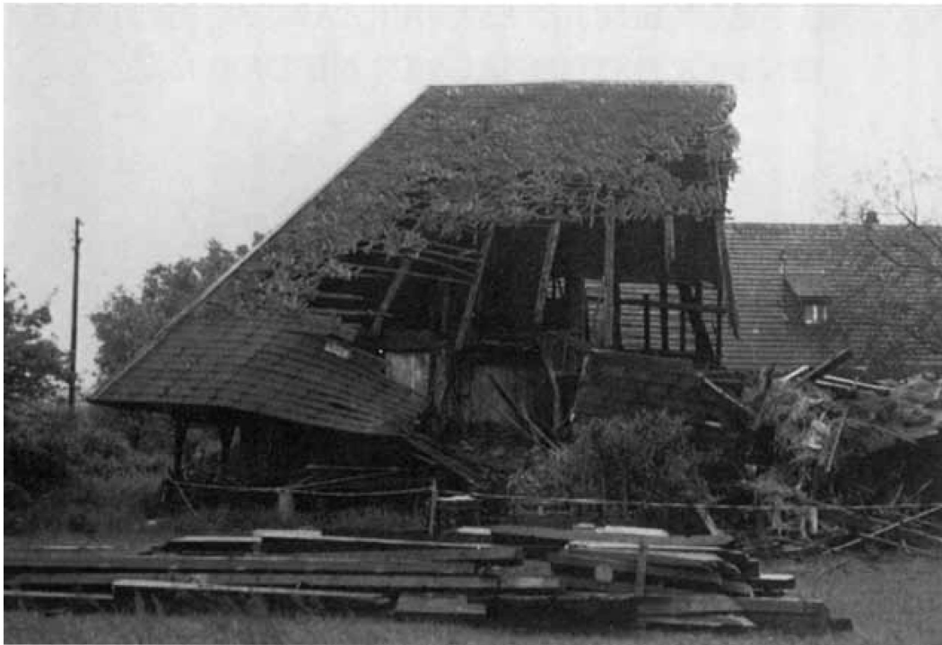
Abb. 1. Das Haus von Niederönz kurz vor dem Abbruch, Mai 1983. Foto W. Gfeller
