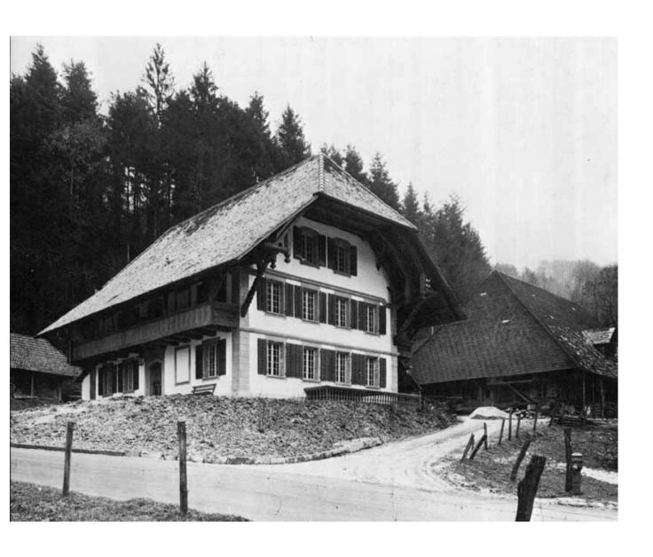
Riedtwil/Seeberg: Gemauerter Wohnstock mit reicher Sandsteinzier (Ecklisenen, Gurtgesimse, Fenstereinfassungen). Krüppelwalmdach mit Gehrschild, dreifaches Flugsparrendreieck zur Abstützung des grossen frontseitigen Vordaches. Traufseitige Lauben im Obergeschoss. Datiert 1811 (Türbogen im Erdgeschoss).
