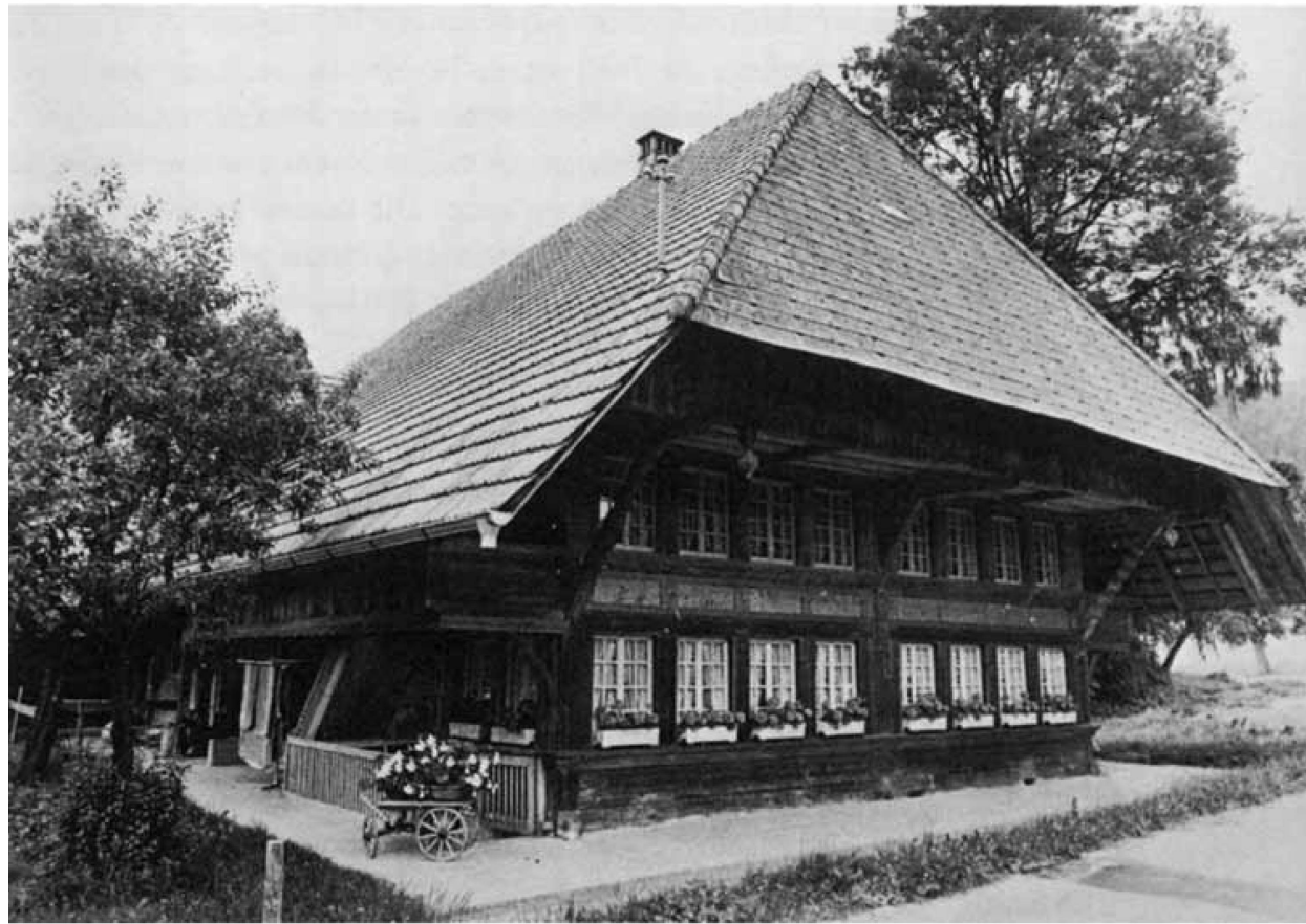
Bauernhaus in Kleindietwil. Bohlenständerbau mit durchgehender Fensterreihe in der Bau- gestalt des 18. Jahrhunderts. Zwei Stuben mit je vier Fenstern. Dreiviertelwalmdach, Büh- nenlaube und traufseitige Gadenlauben. Zwei Zopfbügel mit Datum: 1793. Bei der Restaurie- rung wurden die Fenster in der originalen Sprossenteilung (16 kleine Scheiben) ersetzt.
