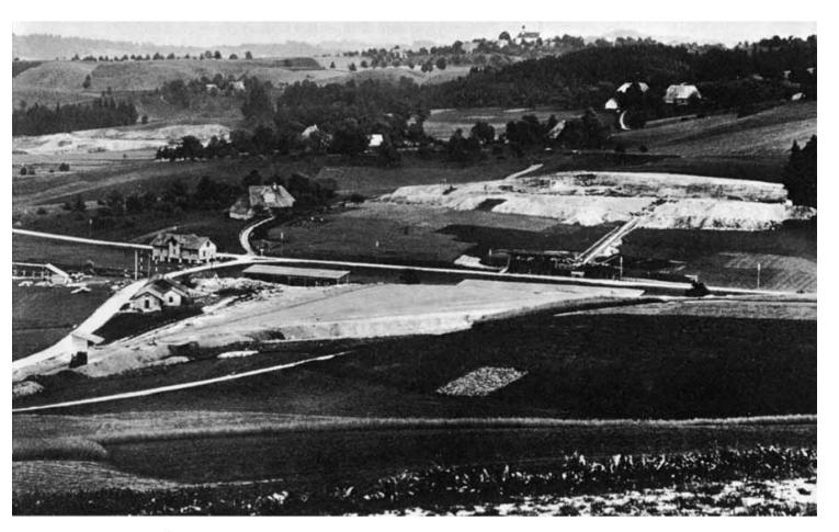
Fig. 3. Überblick über die Abbaustellen in der Umgebung der Haltestelle Gondiswil, vom Pt. 729.2 nordwestlich Hushalden aufgenommen. Im Vordergrund der Abbau bei der Haltestelle, am Gegenhang links die Schürfung Fuchsmatt, rechts die Schürfung Engelprächtigen. In den beiden letztern ist das obere Kohleflöz aufgeschlossen. Im Hintergrund die Kirche von Ufhusen. Aufnahme 27. August 1918, von Johannes Schär, Fribach, Gondiswil.
