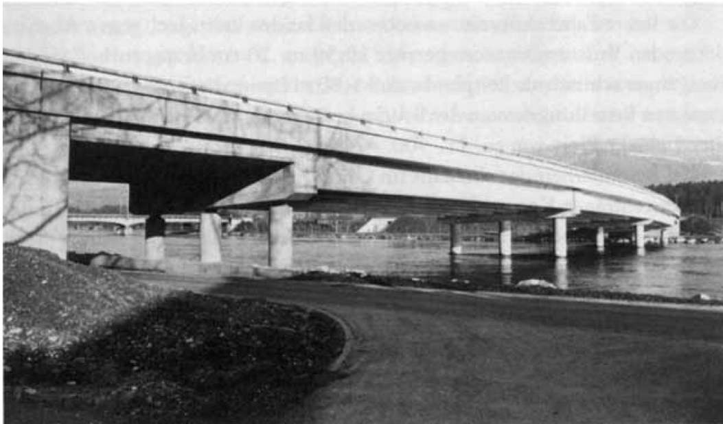
Aarebrücke Wangen, Trägereinbau mit Autokran ab Ponton. Foto Ingenieurbüro Th. Müller, Solothurn.
