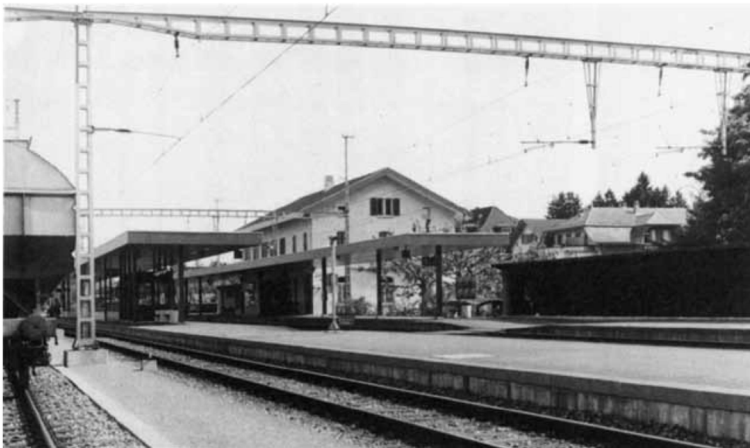
Perron 1 und 2 mit Überdachung. Auffallend gegenüber dem früheren Zustand sind die vereinfachten Fahrdrahtaurhängungen. Auf Perron 2 wurden eine heizbare Wartekabine und andere Sitzgelegenheiten erstellt.
