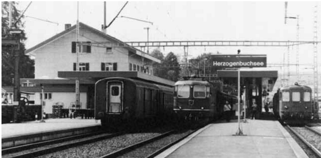
Die neue Perronanlage. Links ein Zug nach Bern (Perron 1), Mitte ein Zug nach Olten (Geleise 2) und rechts ein Zug nach Solothurn (Geleise 3).
