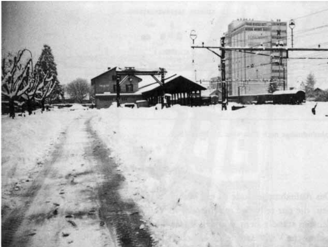
Blick auf den Bahnhof von Nordwesten. Bahnhofstrasse und Bahnhofplatz. Harmonisch wirken die 100 m langen beiden Perronüberdachungen und das Aufnahmegebäude. Totalumbau 1979–1981.
