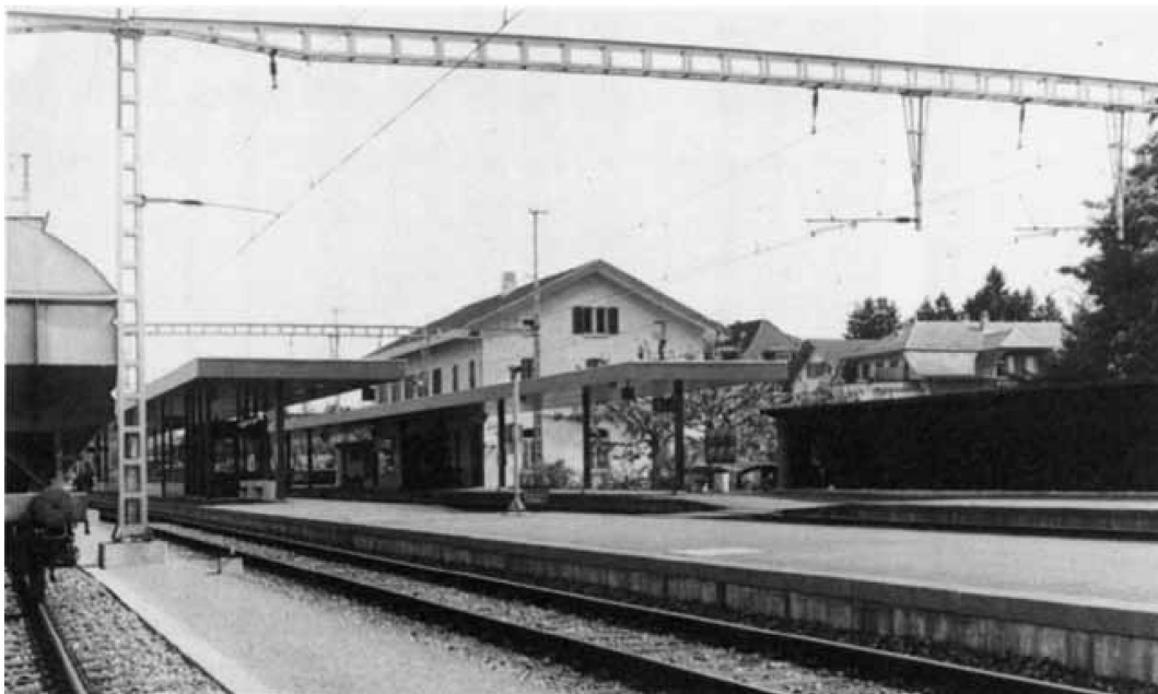
Perron 1 und 2 mit Überdachung. Auffallend gegenüber dem früheren Zustand sind die vereinfachten Fahrdrahtabhängungen. Auf Perron 2 wurden eine heizbare Wartekabine und andere Sitzgelegenheiten erstellt.
