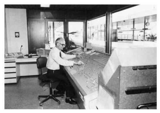
Domino-Stellwerk und elektrische Sicherungsanlagen. Gute Sicht auf die Geleiseanlagen.
