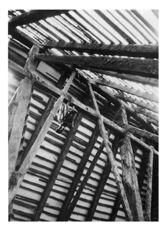
Abb. 4: Ursprünglicher Zustand, Blick gegen den First und den Unterfirst, getragen von zwei Hochstüden, schräg verlaufende Streben.
