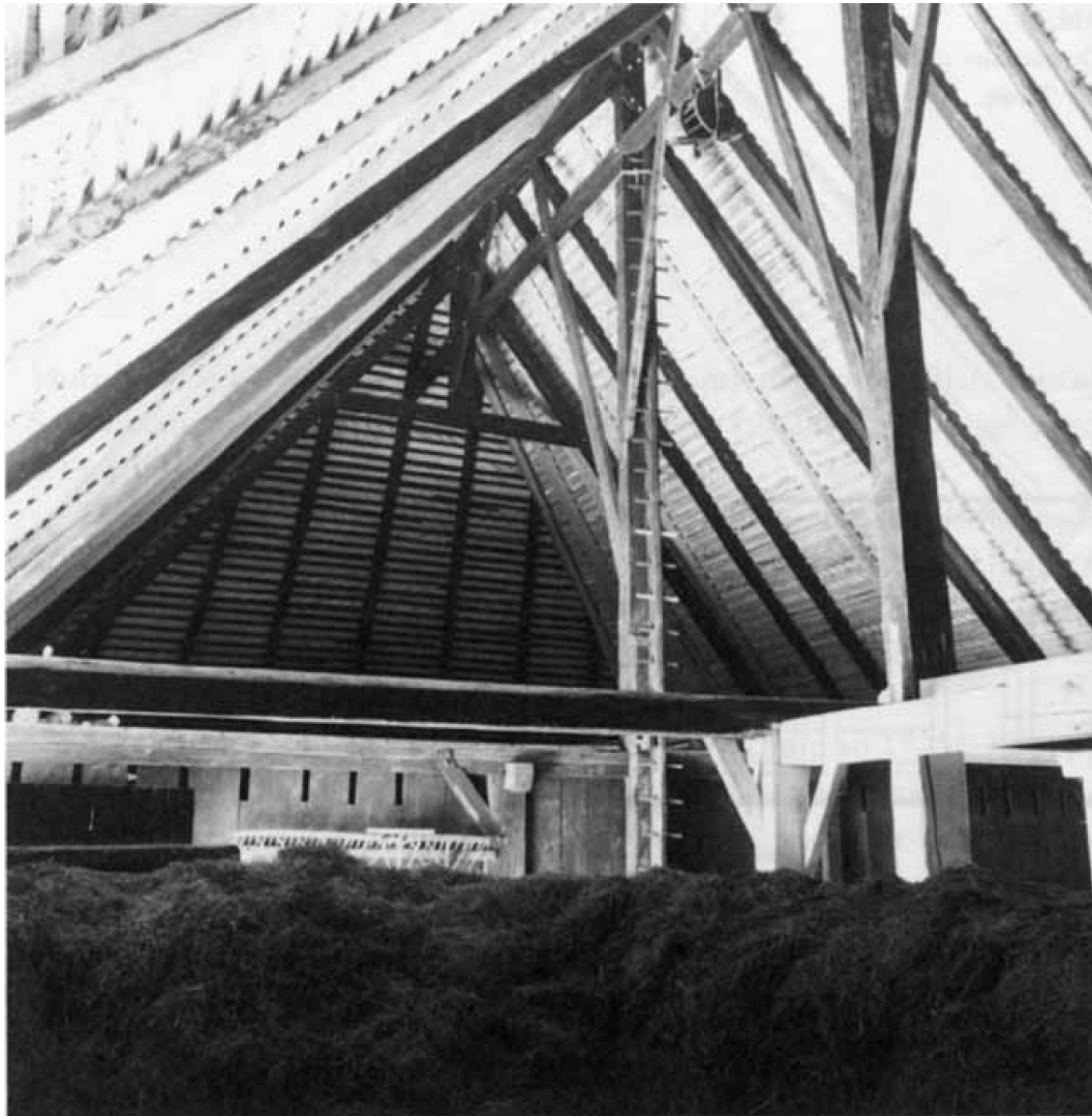
Abb. 5: Blick in den Scheunenraum des wieder aufgebauten Hauses. Hochstüde beidseits des Tenns, eine davon mit Leiterbaum.
