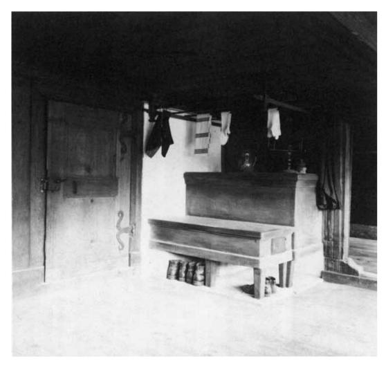
Abb. 10: Stubenofen aus Sandsteinplatten.
