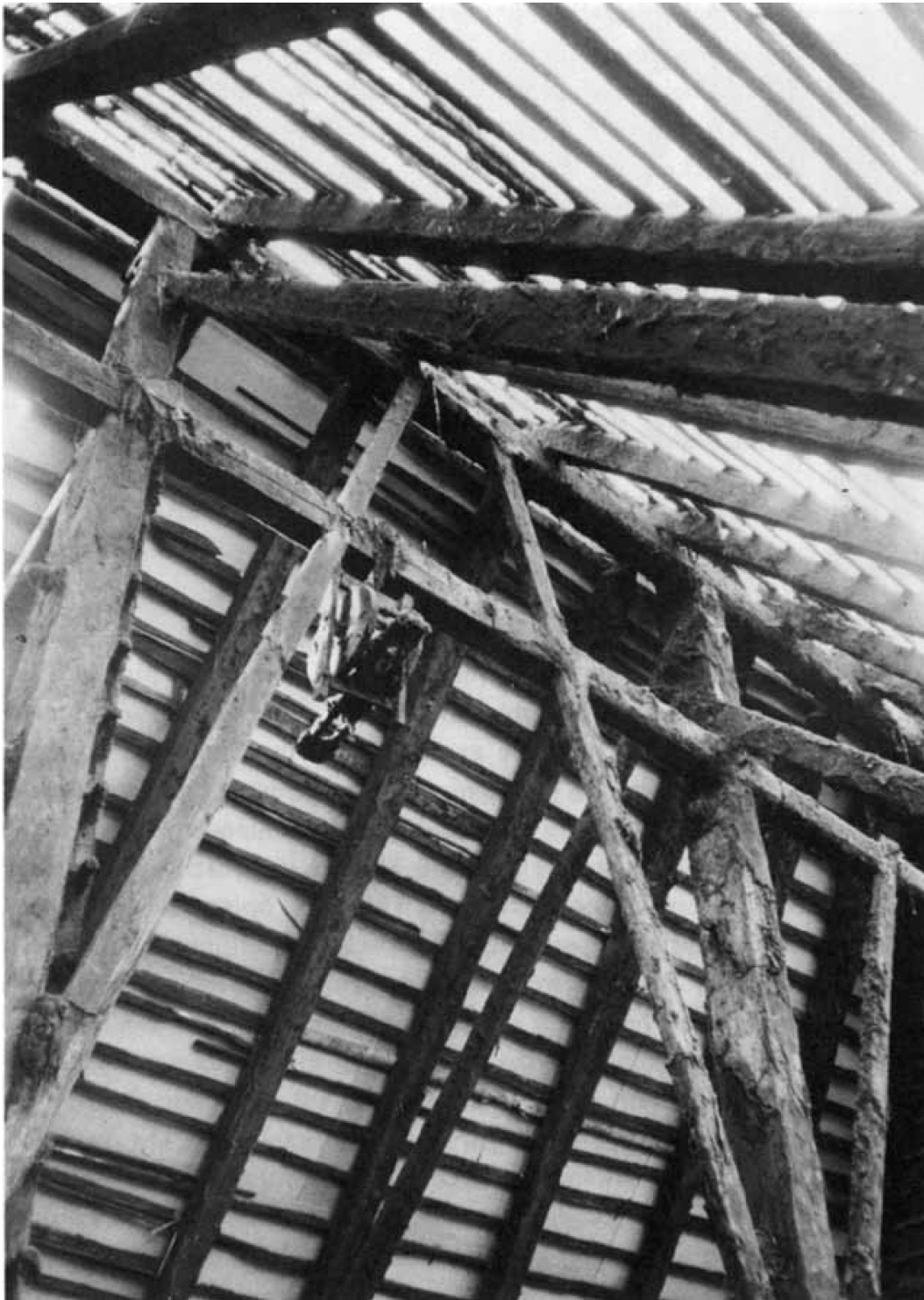
Abb. 4: Ursprünglicher Zustand, Blick gegen den First und den Unterfirst, getragen von zwei Hochstüden, schräg verlaufende Streben.
