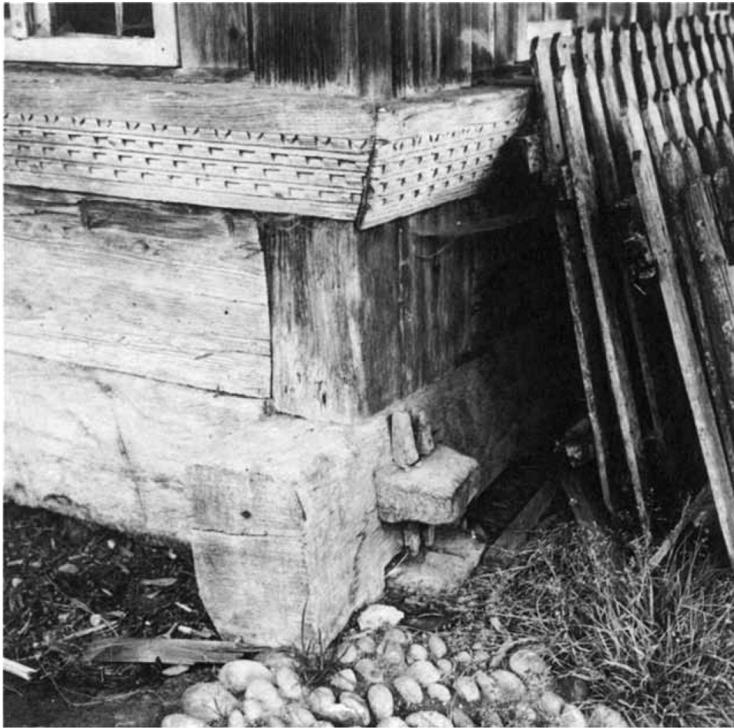
Abb. 12: Hausecke mit durchgesteckten Schwellen, Fensterbank mit Friesen, Aufnahme am ursprünglichen Standort.
