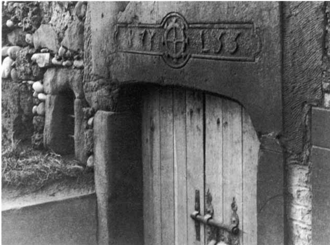
Mühlstöckli Oberönz. Initialen des Jakob Lüthi (YL 1755) über dem Kellereingang.
