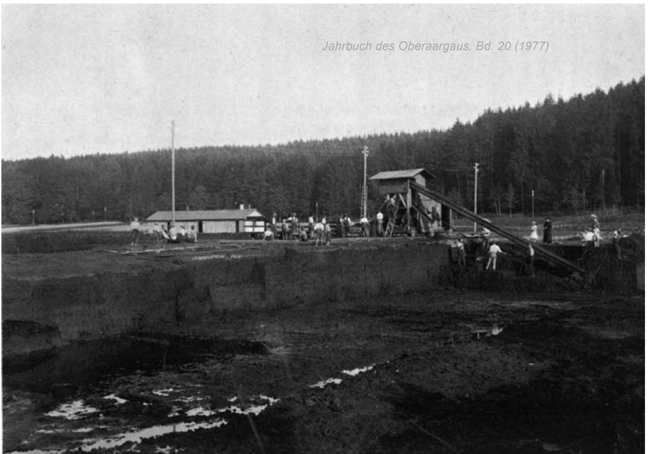
Abb. 1. Die Foto von Jos. Gschwend, Langenthal, zeigt die Torfausbeutung im Bleichenbachmoos im Jahre 1918 mit der ersten Torfmaschine. Im Frühling 1919 wurde eine zweite in Betrieb genommen. Der Geschäftsbericht 1919 meldet zudem die Anschaffung von drei Verladekränen und eine bedeutende Erweiterung der Geleiseanlagen und des Rollmaterials.
