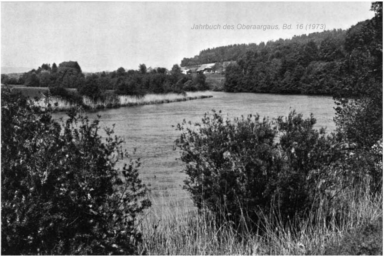
Blick auf den Wynaustau vom rechten Ufer flussabwärts. Im Hintergrund Ober-Wynau. Aufnahme A. Schmalz, 26. 5. 1973.
