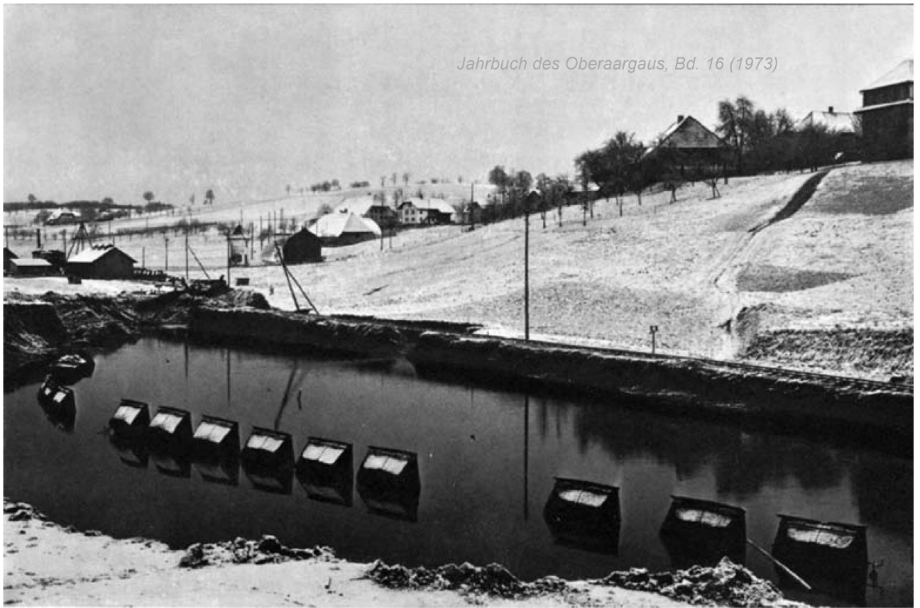
Der Kohlenweiher im Talgrund von Gondiswil. Aufnahme von J. Schär nach einem Wassereinbruch 23./24. Dezember 1918. Im Weiher die «ertrunkenen» Rollwagen.
